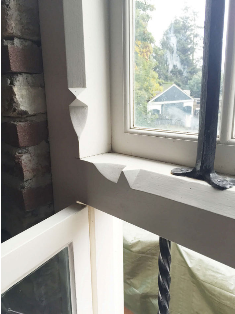
Detail van het nagemaakte kruiskozijn in de opkamer (foto: 2015)
