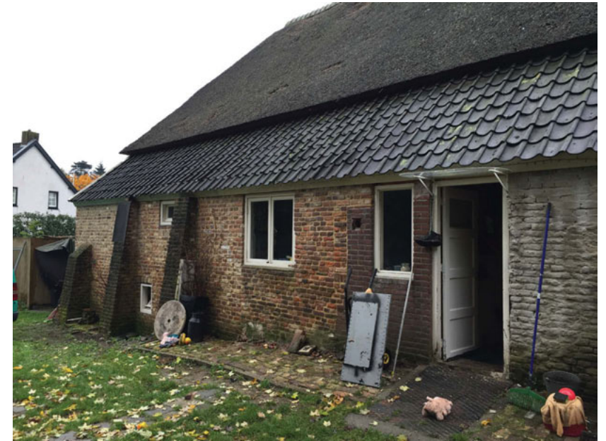
Noordgevel (foto: 2015); het metselwerk links van het brede keukenraam is bij de restauratie in 2005 vernieuwd, uitgevoerd met oude steen, verwerkt in kruisverband. Ook de steunberen zijn nagemaakt, maar gemetseld in contemporaine steen. De steunberen watern in en veroorzaken aan de binnenzijde van de gevel vochtplekken
