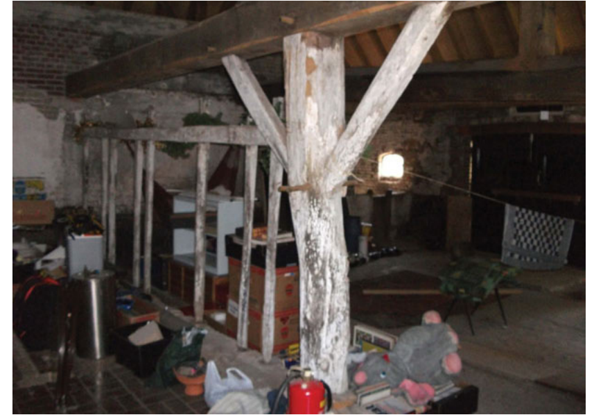
Moerbalkgebint op as D; het gebint is aangebracht op de overgang van voorstal naar potstal (XVIII). Aan de zuidzijde ligt de moerbalk op de gemetselde scheidingwand tussen stal en slaapkamer (XIX). Onder de moerbalk zijn veestijlen aangebracht. De moerbalk is in 2007 vernieuwd (foto: 2010, Remco Luyk)
