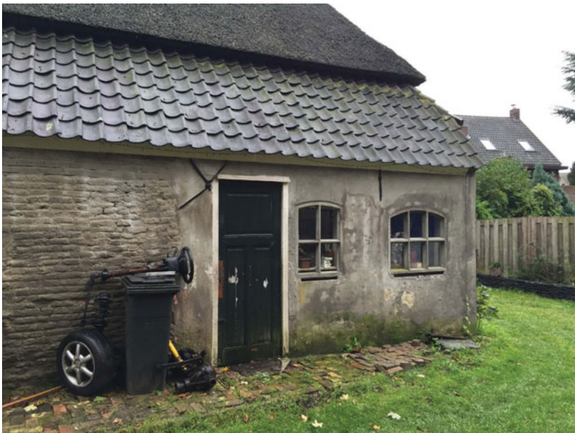
Noordgevel (foto: 2015); staldeur en betonnen stalraampjes uit bouwphase 20 e eeuw. Voor de staldeur is het muuranker aangepast
