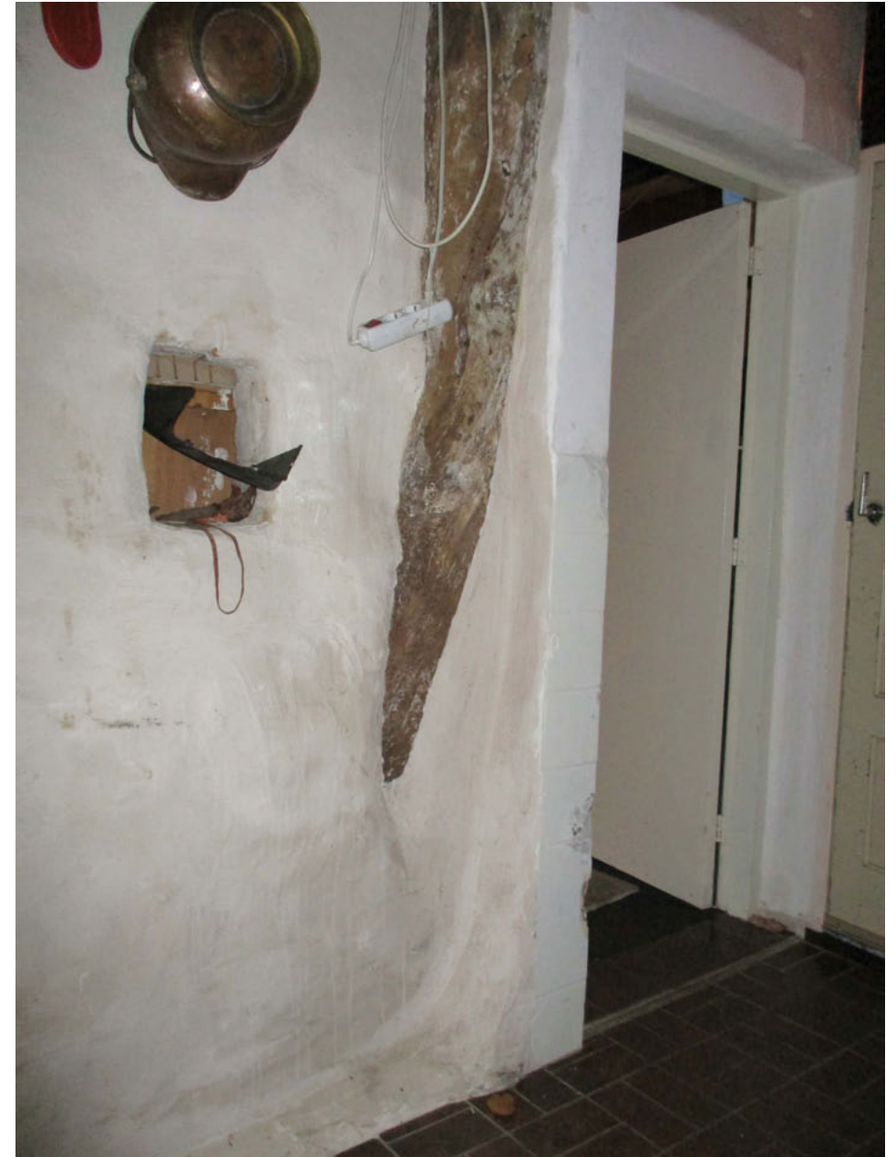
Kijkgat in originele brandmuur vanaf de stalkant gezien (foto: 2015)
