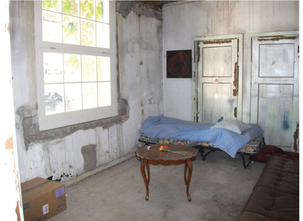
Ruimte 10, slaapkamer (foto: 2010). Deze kamer is waarschijnlijk in de 19 e eeuw van de stalruimte afgeschoten. Het raamkozijn is in 2007 vernieuwd, maar aan de onderzijde iets ingekort om beter te stroken met de andere kozijnen in de voorgevel. De bovenste 4 rijen metselwerk zijn vernieuwd, om de nieuwe muurplaat onder de kapconstructie vlak te kunnen aanbrengen. Op de vloer keramische plavuizen, 225x225mm, in het zand gelegd
