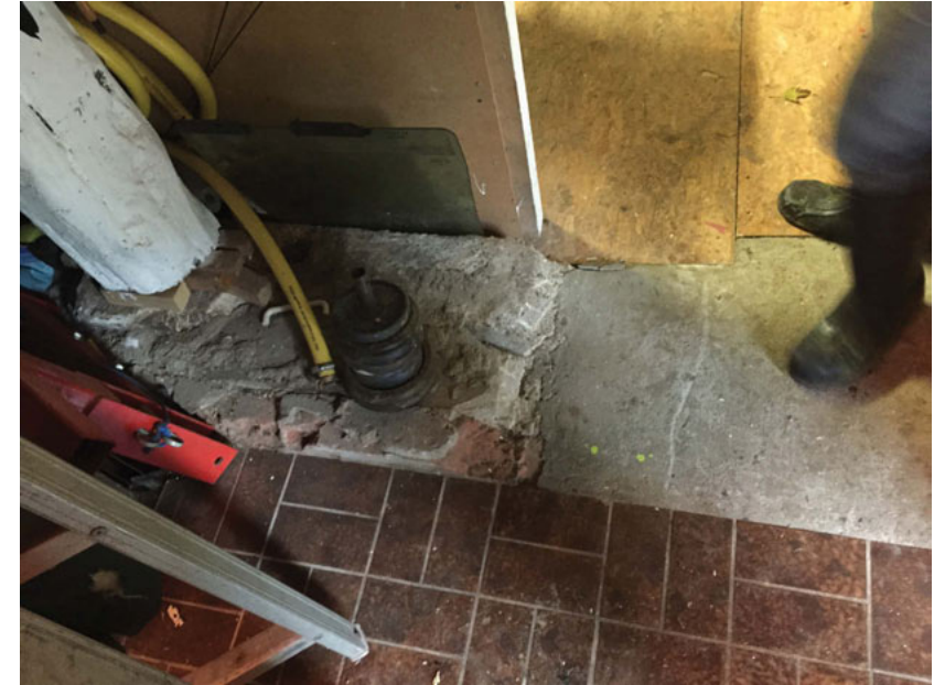
Moerbalkgebint op as D, detail van de voet van de standvink. Bij de laatste restauratie (2005) is de stijl opgewigd. Houten klossen zijn nog zichtbaar. Het gemetselde fundament onder de stijl vormt de scheiding tussen de voorstal en de lager gelegen potstal (foto: 2015)
