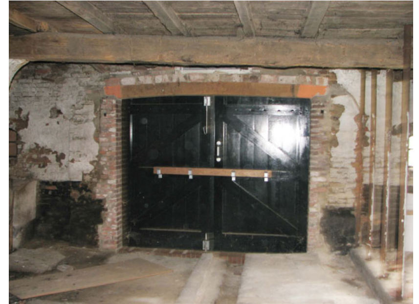
Stal. In de loop van de 20 e eeuw is de potstal omgebouwd tot kleine grupstal met een mestgoot in het midden. De goot voert de mest naar een gierkelder onder de stalvloer. De dubbele staldeur is toen vervangen door een enkele deur en een stalraam, zoals zichtbaar is op enkele zwartwit foto's die rond 1960 zijn gemaakt. In 2003 is de dubbele deur weer teruggebracht. In de huidige situatie is de stalvloer afgedekt door een houten vloer (foto: 2007 voor restauratie)
