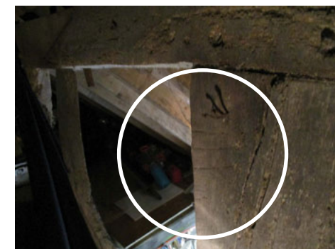
Ankerbalkgebint op as C (foto: 2015); met gekrast telmerk: III
