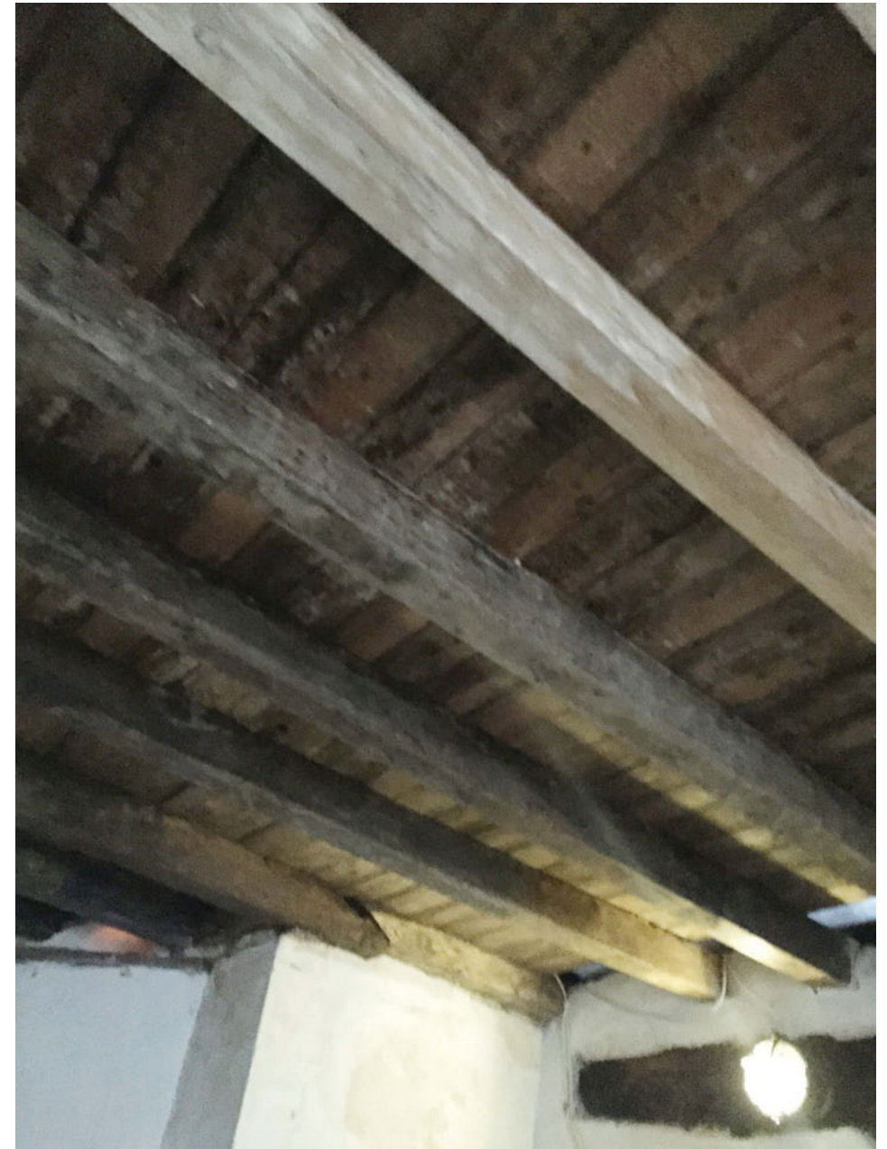
De balklaag boven Ruimte 2 overspant tussen gebinten op as B en C. Deze balklaag loopt door in de keuken, Ruimte 4, tot aan de gebintstijlen (foto: 2015)
