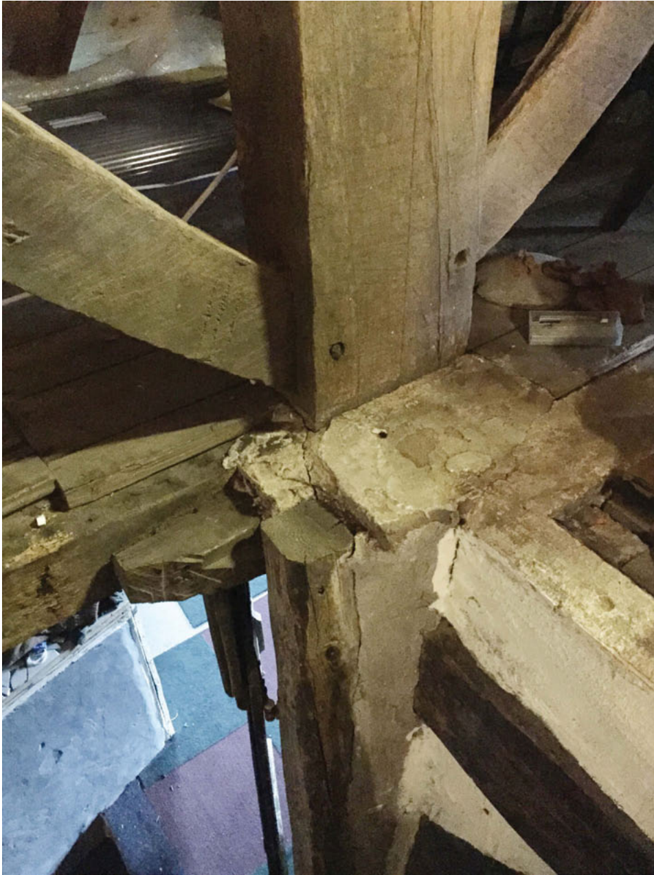
Gebintstijl noordzijde ter hoogte van ankerbalkgebint II. Op beide schoren is het gekraaste telmerk II zichtbaar. Tegen de gemetselde muur onder de ankerbalk is een gehakte houten stijl aangebracht waaraan een opgeklampt deurtje is gehangen (foto: 2015)
