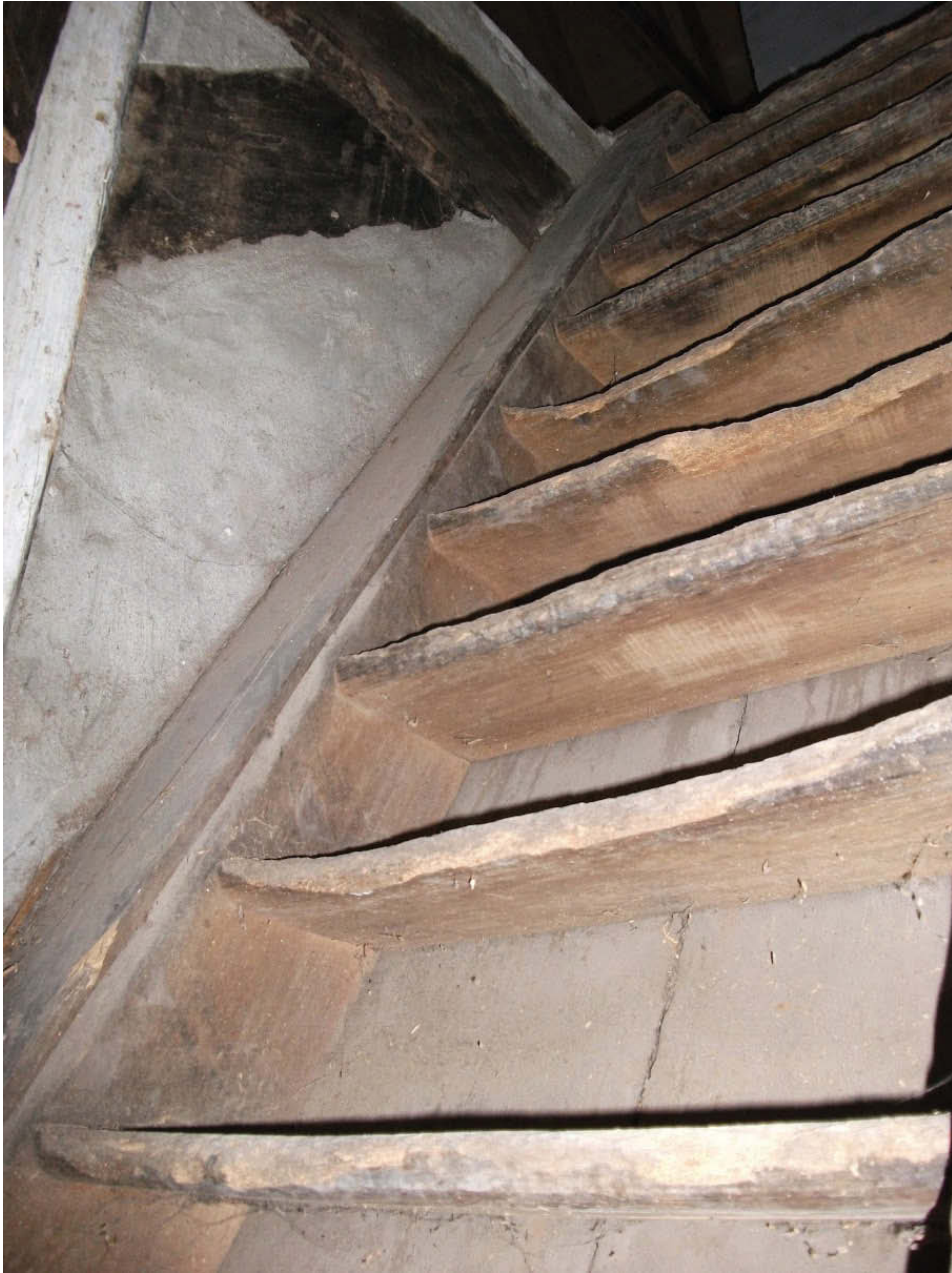
Steile eikenhouten steektrap van opkamer naar zolder (foto: 2010)
