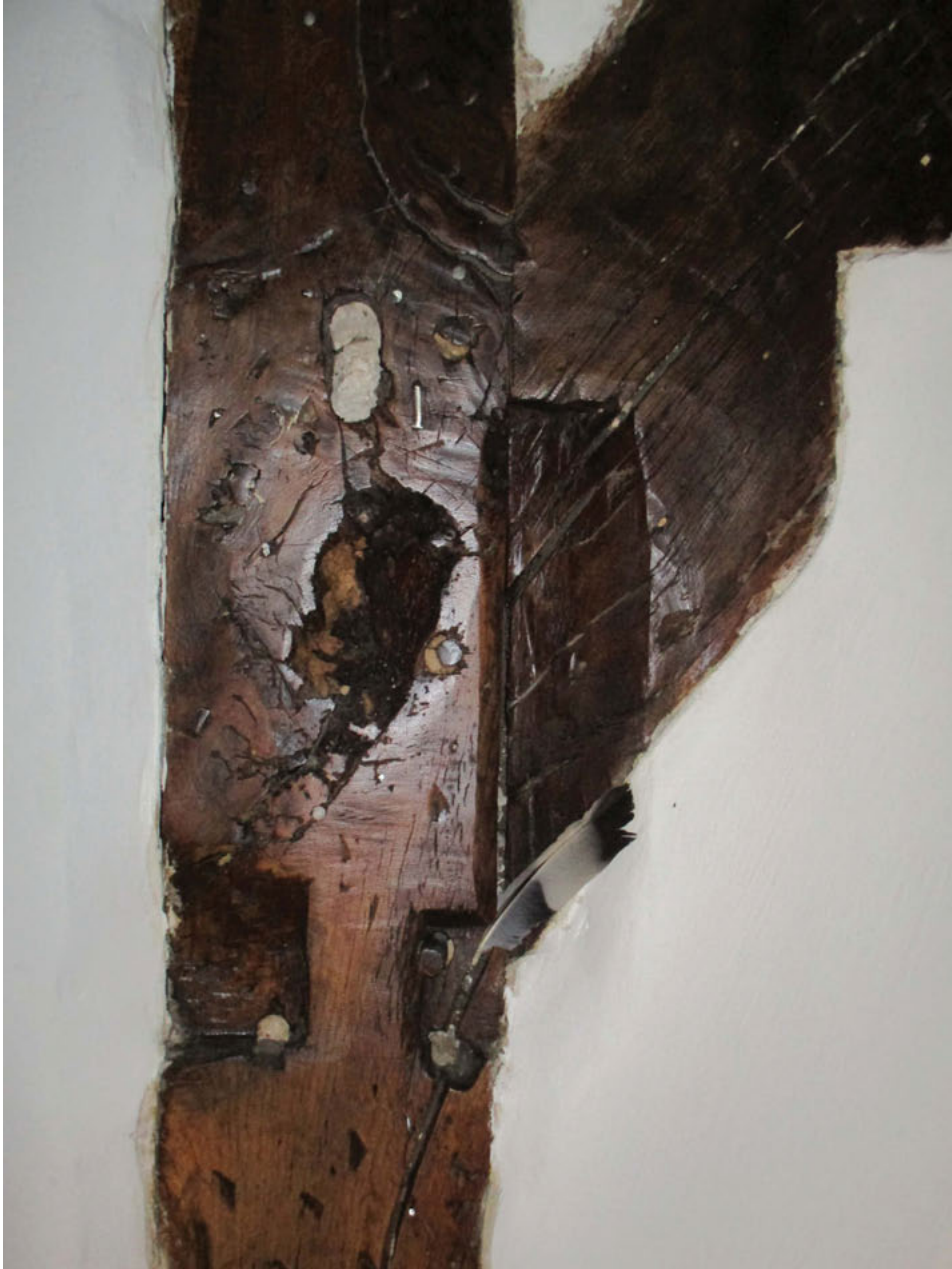
Ankerbalkgebint II aan zuidzijde gezien vanuit woonkamer (foto: 2015)
