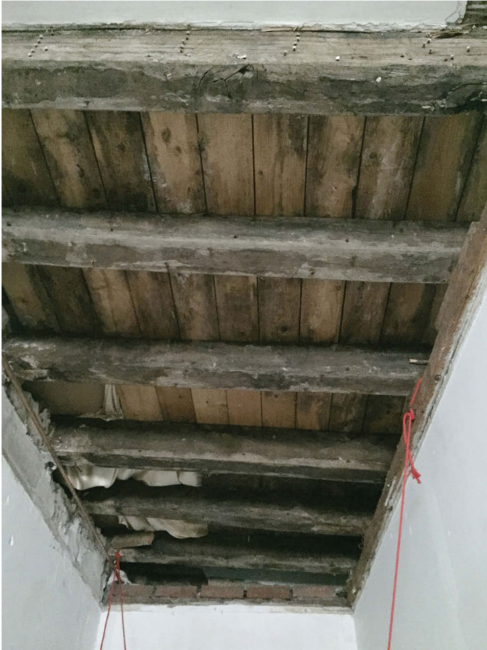
Balklaag boven ruimte 1 (entreehal). De balken rusten op de ankerbalken van de gebinten op as B en C. De balken lopen door in ruimte 2 (foto: 2015)
