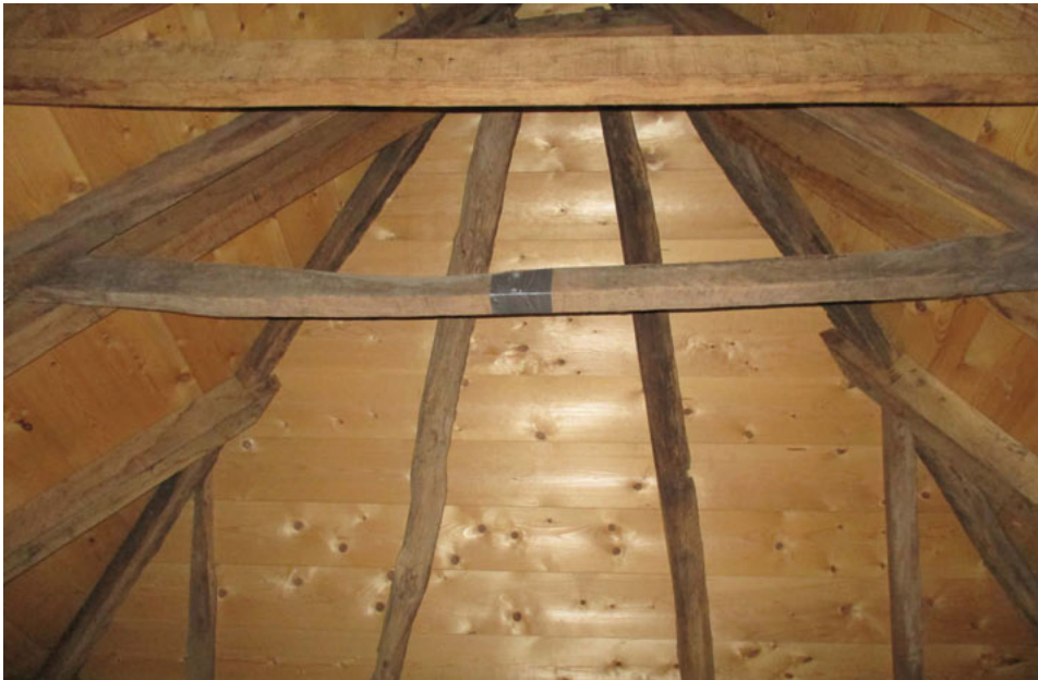
Het wolfseind boven de oostgevel. Bij de restauratie in 2005 zijn de muurplaat en sporen gehandhaafd. De muurplaat zou deel hebben uitgemaakt van een vakwerkconstructie van het overstekende zolderfront uit de tweede fase (XVII). De hoekkepers steunen af op een A-spantje met dubbel haanhout (XVII) (foto: 2015)
