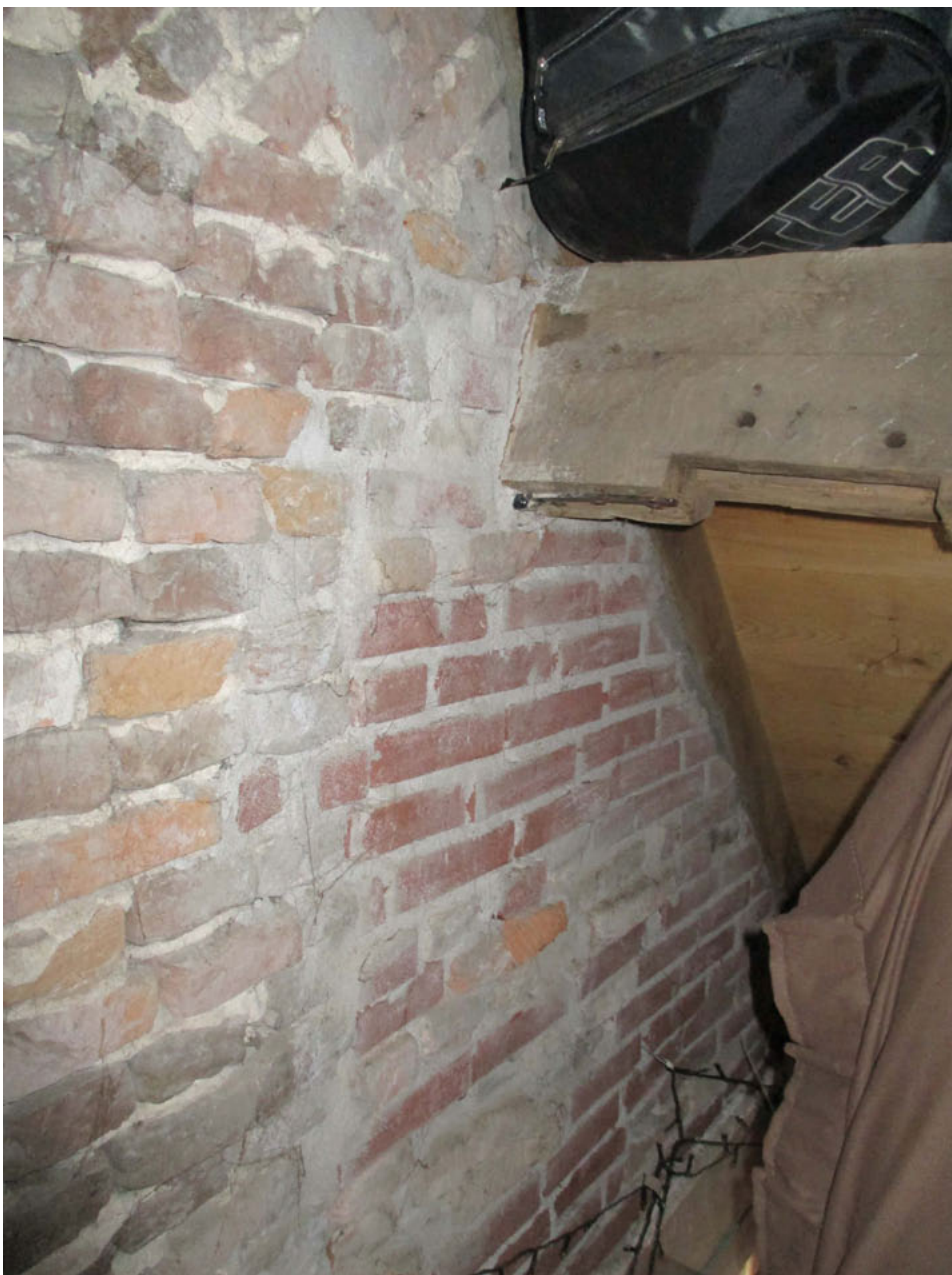
Oplegging van gebintplaat op oostgevel (XVIII). Voor de oplegging is een pengat zichtbaar, mogelijk van het 1e ankerbalkgebint dat in de achttiende eeuw vervangen werd door een gemetselde gevel (foto: 2015)
