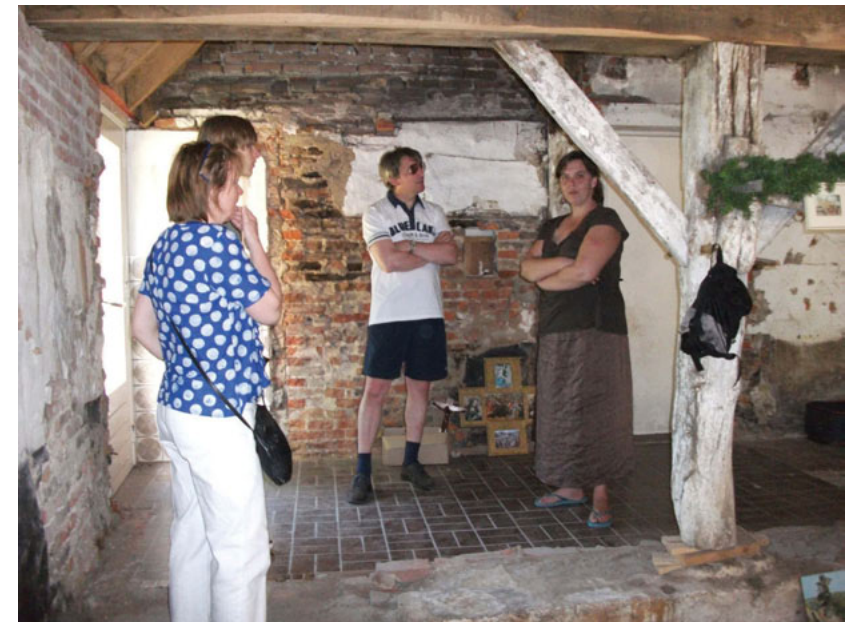
Moerbalkgebint op as D, gezien vanuit de stal. De gemetselde wand onder het ankerbalkgebint op as C is links van de gebintstijl, boven het niveau van de zuidgevel, verhoogd met een veel jongere steen (foto: 2010, Remco Luyk)
