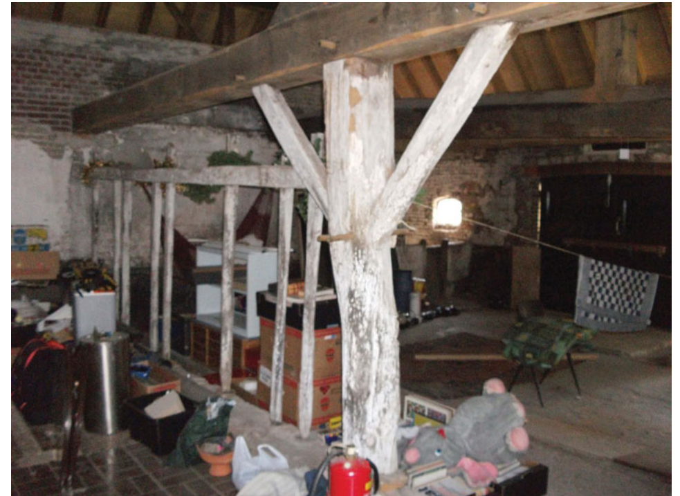
Resterende veestijlen. Na de restauratie is de halfteens muur achter de veestijlen afgebroken (foto: 2010)
