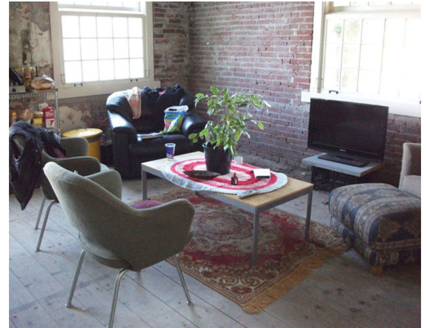
Ruimte 3a, woonkamer (foto: 2010); in de zuid-oosthoek is het metselwerk vernieuwd. De herstelwerkzaamheden zijn in contemporaine steen uitgevoerd
