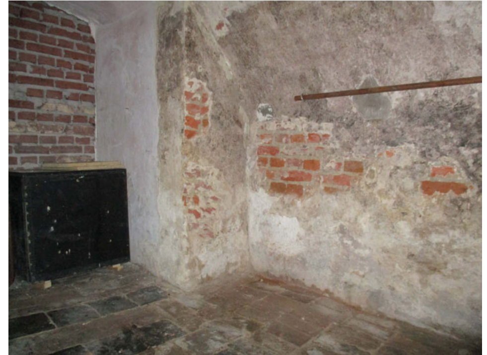
Kelder naar oosten gezien. Links in de achtergrond het metselwerk zichtbaar van de vernieuwde oostgevel. Rechts is de zachte rode baksteen zichtbaar van het metselwerk uit de tweede bouwphase (XVII). Dezelfde steen is zichtbaar in het muurwerk onder de gebinten. De vloer is betegeld met geglazuurde plavuizen in twee kleuren (foto: 2015)
