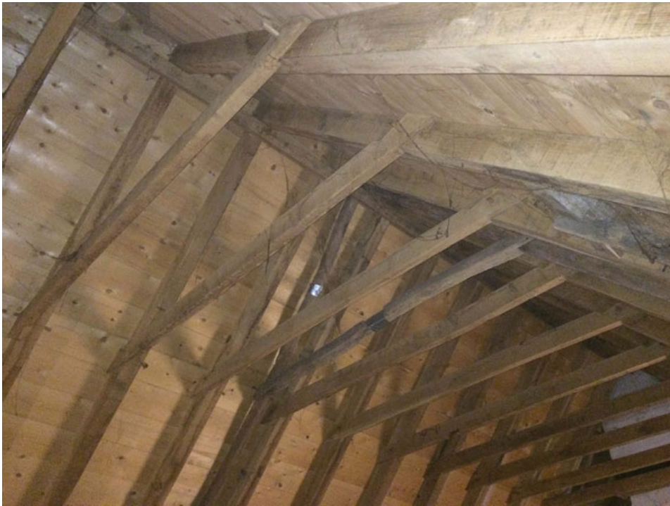
Vernieuwde sporenpanten en dakbeschoot. Van de oude sporenpantjes zijn er vier behouden (foto: 2015)
