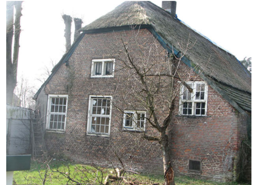
Oostgevel (2007, voor restauratie)
