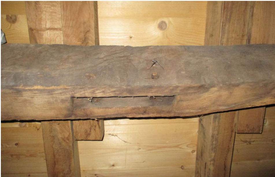
Oude pentgat van gebint II in de oorspronkelijke gebintplaat (foto: 2015)
