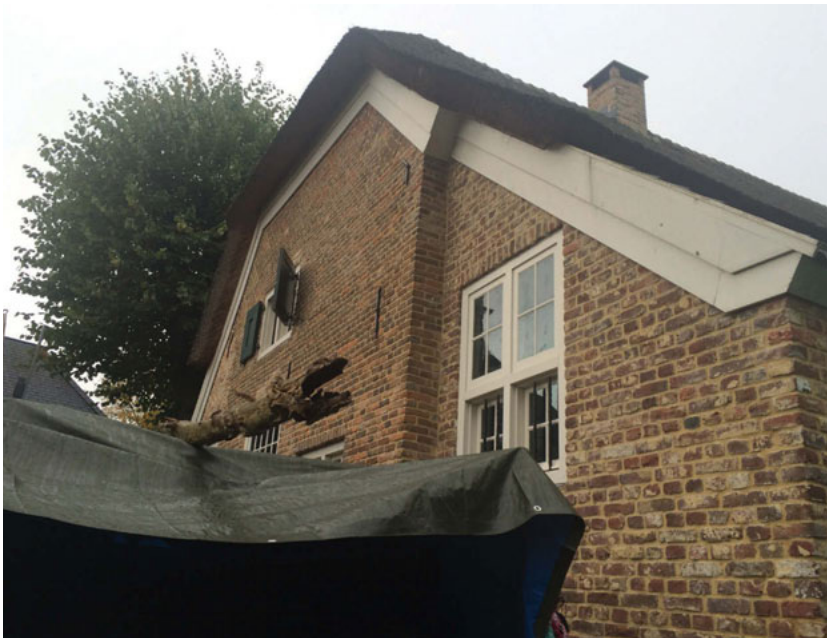
Oostgevel (foto: 2015). Metselwerk van de noordelijke zijbeuk is in 2005 geheel vernieuwd met oude steen. Het overige metselwerk is grondig gereinigd en opnieuw gevoegd. Rondom de kozijnen inboetwerk. Kozijnen geheel vernieuwd. Onder het rieten overstek dubbele boeidelen aangebracht en over de pannen een windveer
