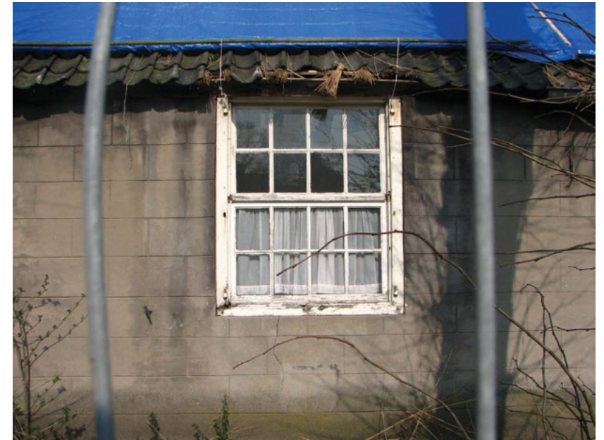
Zuidgevel (foto: 2007, voor restauratie); raamkozijn van ruimte 10, de van de stal afgeschoten kamer (XIX)
