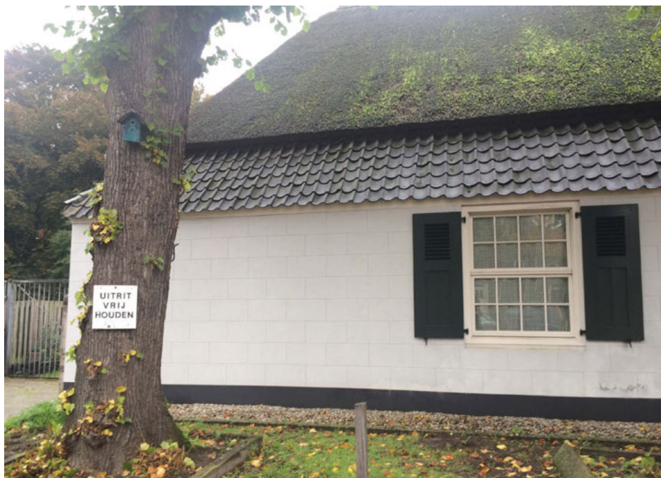
Zuidgevel (foto: 2015). Dakbedekking vernieuwd, kozijn en luiken vernieuwd en pleisterwerk vernieuwd en geschilderd. De schijnvoegen in het pleisterwerk en het nieuwe kozijn is op elkaar afgestemd
