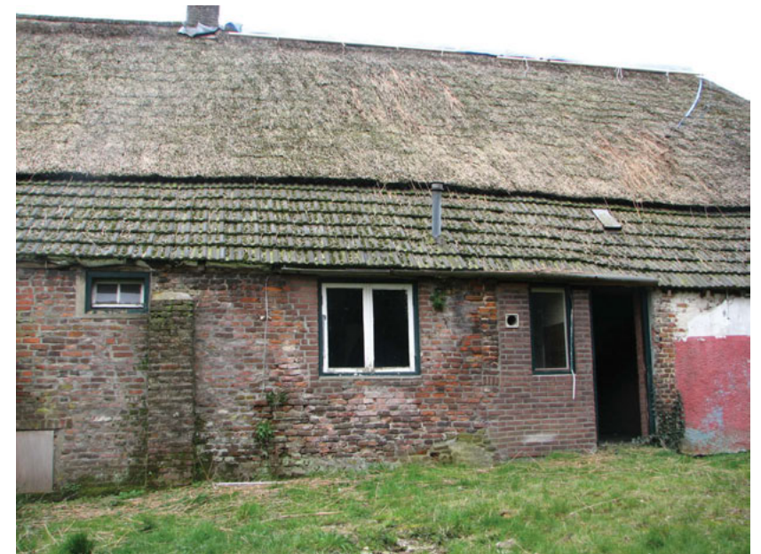
Noordgevel; de achtergevel ter plaatse van keuken en achteruitgang. Keukenramen en de achterdeur zijn ingemetseld met een moderne vormbaksteen. Rondom het smalle keukenraam is het nieuwe metselwerk in hafsteenverband uitgevoerd (XXc). Het oude metselwerk is als vuilwerk uitgevoerd. Er valt geen verband in te ontdekken (foto: 2007 voor restauratie)
