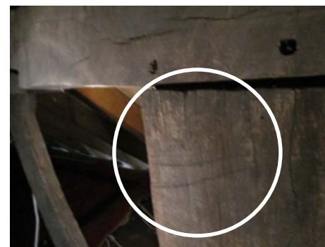
Ankerbalkgebint op as B (foto: 2015); met gekrast telmerk: II
