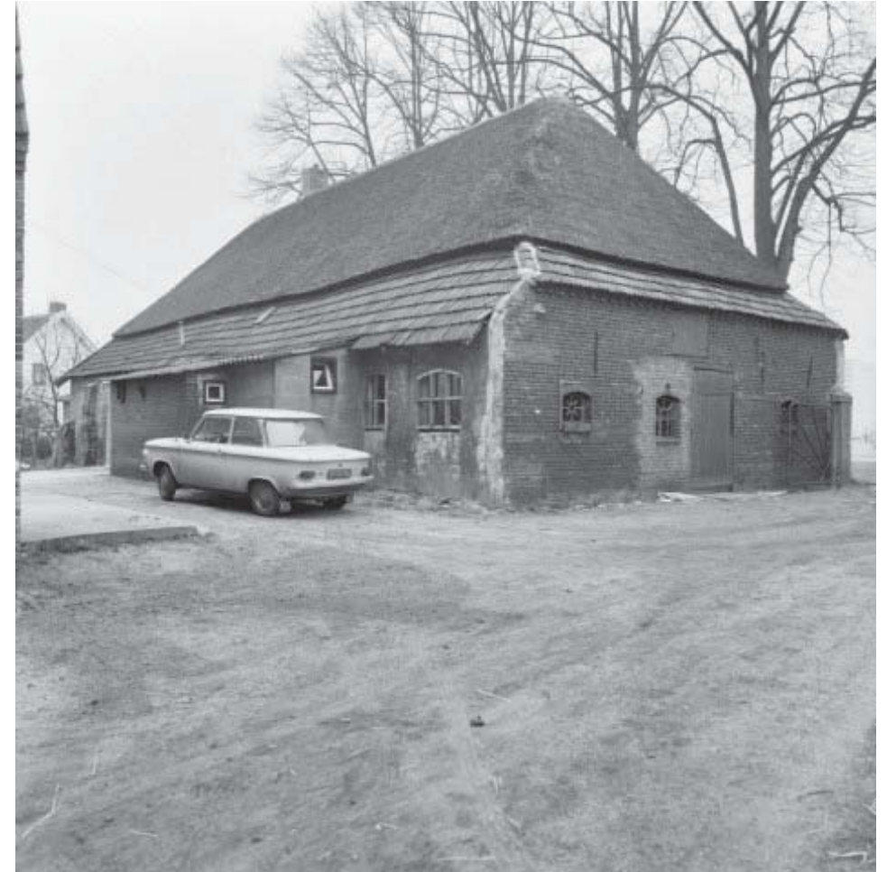
Noord- en westgevel in 1967 met aanbouw aan noordgevel en de westgevel met de staldeur waarvan de linkervleugel was dichtgemetseld en voorzien van stalraampje (foto: 1967)
