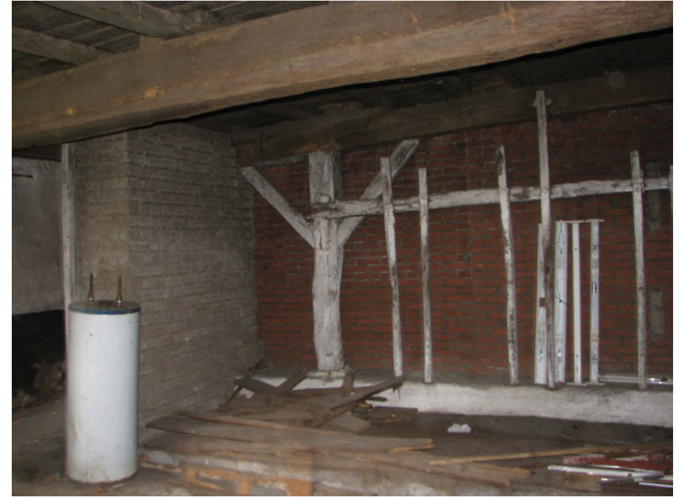
Stal, gekeken naar het moerbalkgebint op as D. Achter het gebint is een halfsteens gemetselde wand zichtbaar, die de scheiding vormt tussen stal en woonhuis. Voor het gebint ligt een verhoogde vloer voor enkele koeien. De lager gelegen vloer loopt sterk af richting gierkelder (foto: 2007 voor restauratie)
