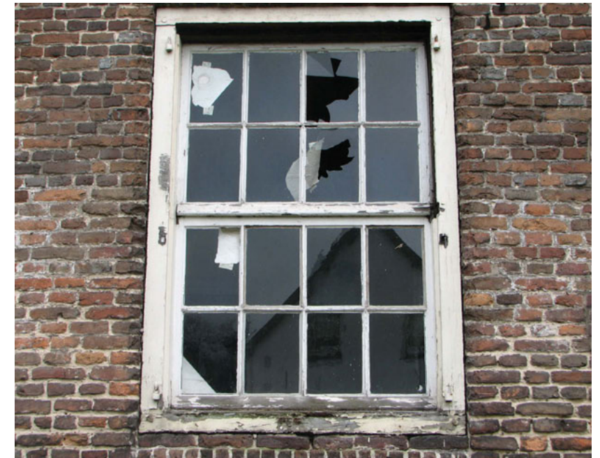
Oostgevel (foto: 2007, voor restauratie); raamkozijn van de woonkamer. Opmerkelijk is dat voor de nieuwe luiken het metselwerk langs de stijlen is afgesloten
