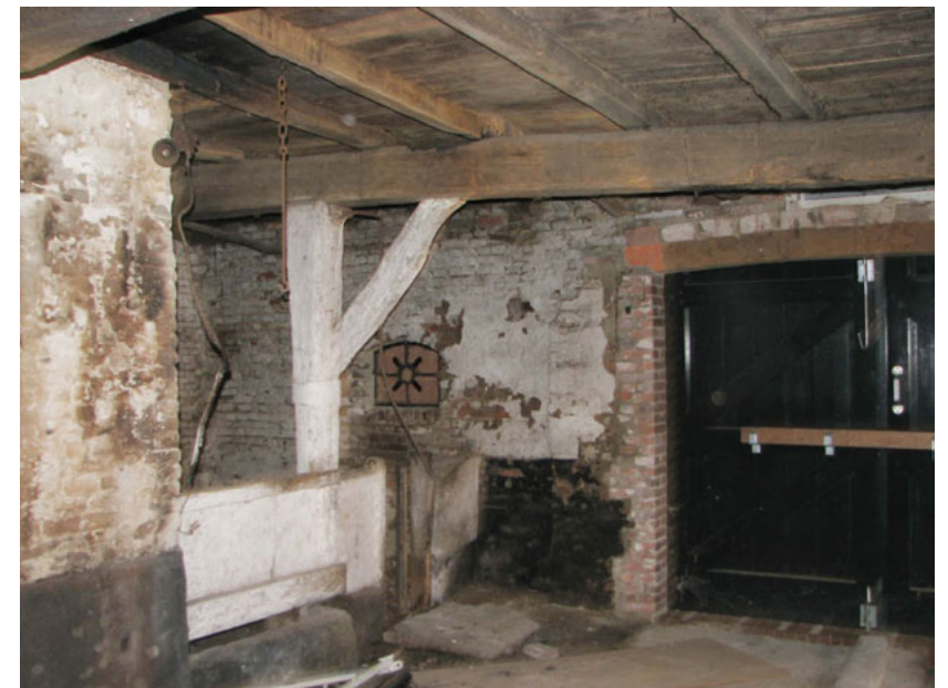
Stal, moerbalkgebint op as F, ondersteund door een standvink aan de zuidzijde. Achter de standvink is een varkenshok zichtbaar met een stenen voederbak (foto: 2007 voor restauratie)
