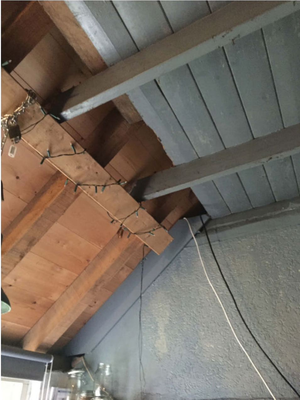
Balklaag boven Ruimte 4, de keuken, eindigt tegen het dakschild (foto: 2015)
