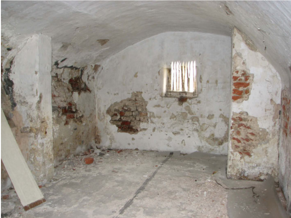
Kelder (foto: 2007, voor restauratie). Onder de getraliede ventilatieopening in de oostgevel is het oorspronkelijke metselwerk met opvallend grote, oude stenen nog zichtbaar. De binnenwanden en het gewelf zijn gemetseld met een zachte rode baksteen. Tijdens de restauratie is de oostgevel opnieuw opgemetseld en zijn aan de binnenzijde moderne stenen in Waalformaat gebruikt. Ook de juist voor deze zuivelkelders karakteristieke getraliede ventilatieopening is helaas vernieuwd; de tralies zijn verdwenen en er is een kozijntje ingemaakt met venster. Links en rechts op de foto zijn zichtbaar interne steunberen, geen penanten, die men later heeft aangebracht omdat de overkluizing kennelijk te zwaar was en de muren uiteendrukte (een onlogische maatregel). Nog later zijn de steunberen aan de buitenkant bijgemetseld. Deze interne en de externe steunberen zijn inmiddels tijdens de restauratie geheel vernieuwd.
