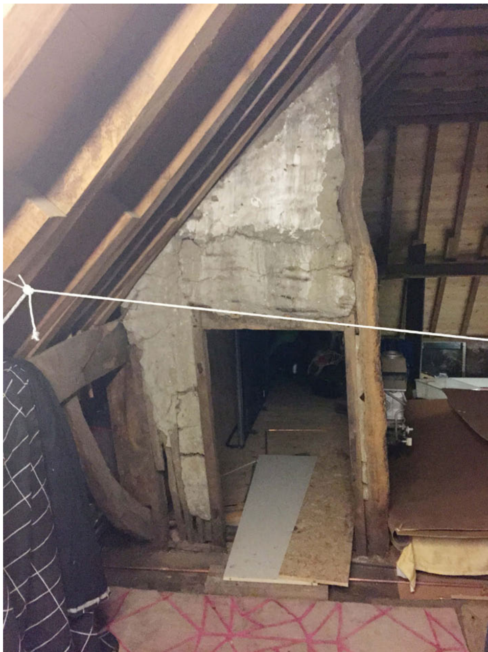
Tegen de zuidelijke gebintstijl van ankerbalkgebint III staat op de zoldervloer een stukje wand van 'vitselstek' met een kozijntje. Dit zou nog een overblijfsel kunnen zijn van een vakwerkwand die de opslagzolder boven het woonhuis van de hooizolder boven de stal scheidde. (foto: 2015)
