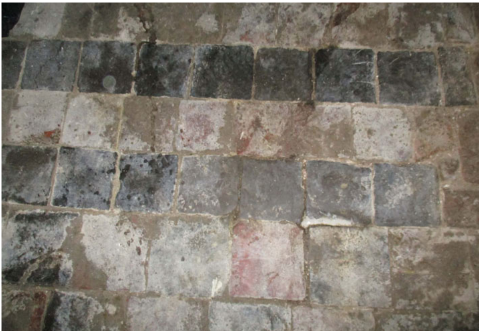
Originele plavuizen in de kelder (foto: 2015)
