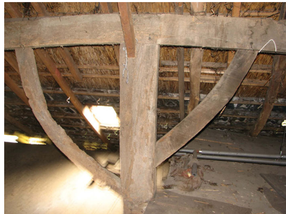
Ankerbalkgebint op as C (foto: 2007, voor restauratie); de noordelijke gebintplaat loopt hier nog door. Bij de restauratie is de gebintplaat links van de linker schoor vervangen.
