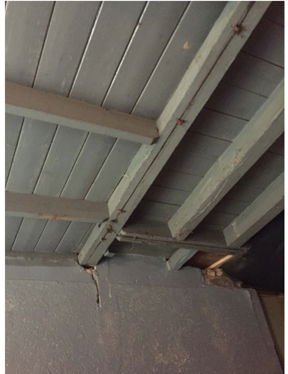
Balklaag boven Ruimte 4, de keuken. Ter hoogte van de gebintstijlen draait de overspanningsrichting. Vloerhout en balkhout zijn hier aanmerkelijk jonger (foto: 2015)
