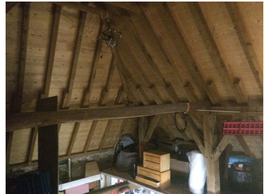
Vernieuwde kapconstructie boven staldeel, noordwest-hoek (foto: 2015)
