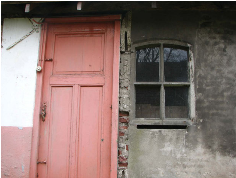
Detail noordgevel; tussen stalraam en deur zijn sporen van de uit betonblokken opgetrokken wand van de uitbouw zichtbaar. Op het gevelvlak naast de deur bevinden zich resten van verschillende binnenafwerkingen (foto: 2007 voor restauratie)
