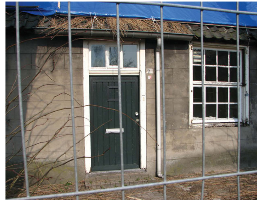
Zuidgevel (foto: 2007, voor restauratie); kozijn van de entree deur met randprofilering en geprofileerd kalf (XVIII) op natuurstenen dorpel. Deur en bovenlicht zijn van een latere fase (XXa)
