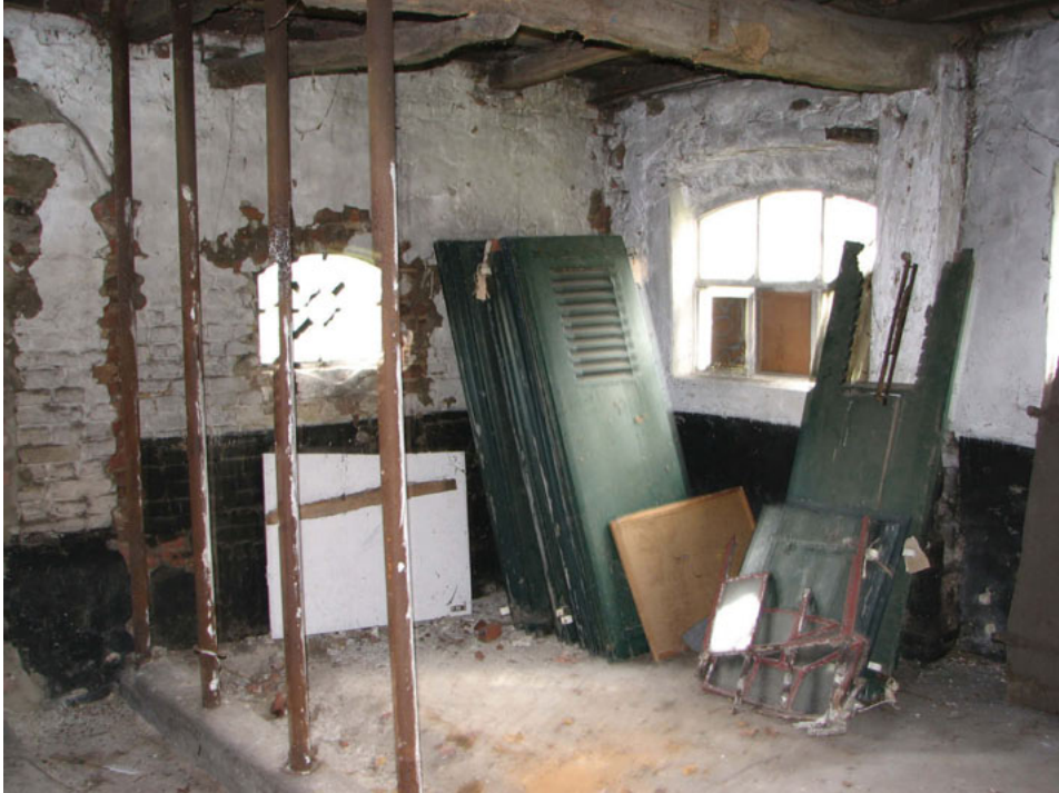
Stal, noordwest hoek. Hier zijn de luiken van de kozijnen in zuid en oostgevel opgeslagen. Vanaf de westgevel tot aan het moerbalkgebint op as F zijn stalen veestijlen aangebracht. Deze stijlen houden verband met een modernisatie van de stal, in de eerste helft van de 20 e eeuw. De zware moerbalk is opgelegd op een gekapte muurstijl zonder schoor (foto: 2007 voor restauratie)
