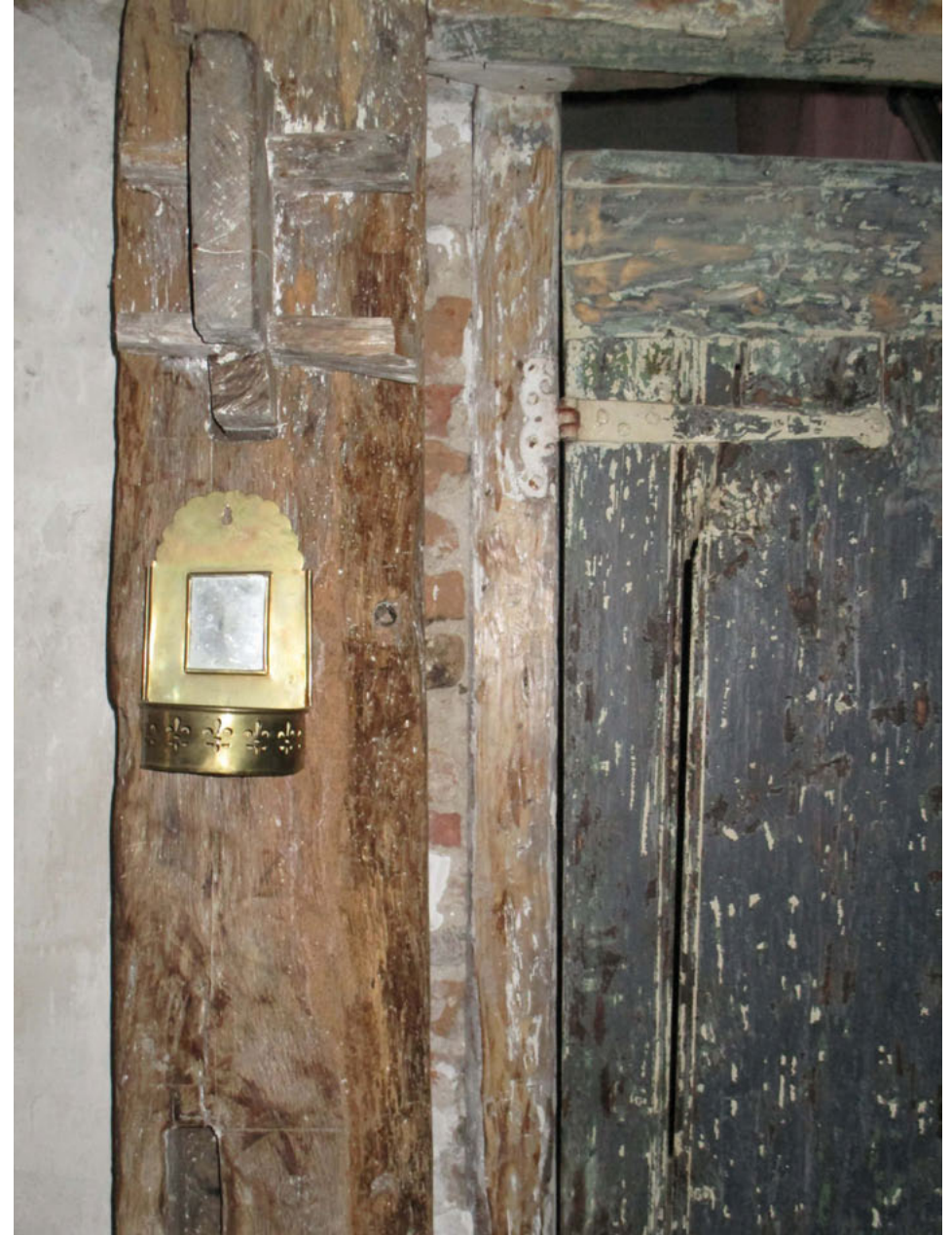
Detail van deur in opkamer naar de zolder tegen ankerbalkgebint II met origineel geheng (foto: 2015)
