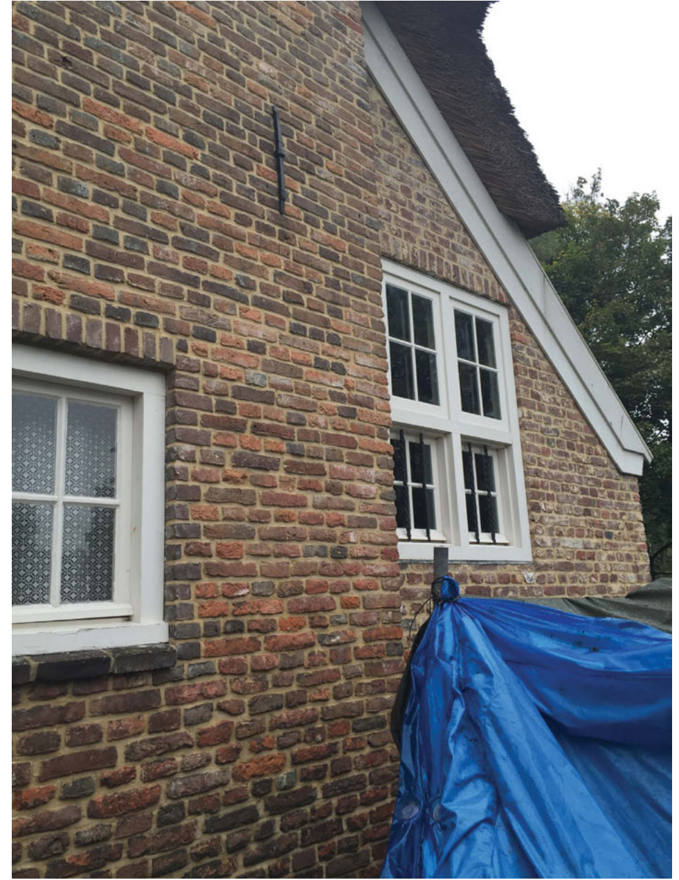
Oostgevel (foto: 2015); vernieuwd kruiskozijn in gereconstrueerd metselwerk. Drie van de vier smeedijzeren tralies in het kruiskozijn zijn hergebruikt. De vierde tralie ontbrak en is nagemaakt. Het kozijn op de voorgrond (XXa) is nog het enige oorspronkelijke kozijn in deze gevel
