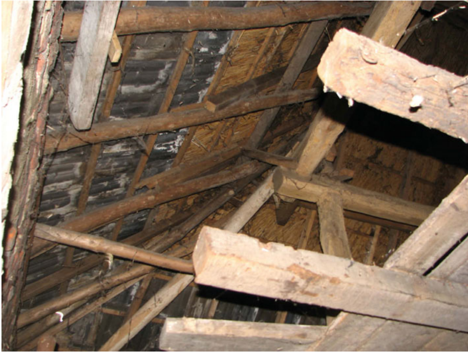
Kapconstructie, gekeken naar de noordwest hoek boven de stal. Op de moerbalk staat een ongeschoorde stijl die de noordelijke gebintplaat ondersteunt. De gebintplaten zijn verbonden door een koppelbalk parallel aan de westgevel. Geschilde sparren zijn de dragers van het onderste deel van de dakconstructie. Hier overheen is een gezaagde gording aangebracht die die sporen van het bovenste deel van het dakvlak moet opvangen. De gording wordt afgesteund op de koppelbalk (foto: 2007 voor restauratie)
