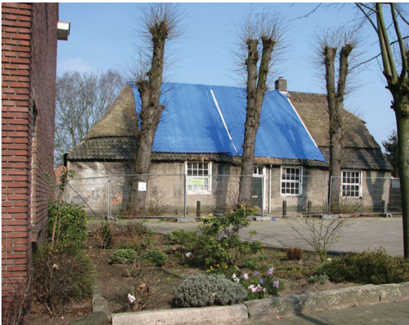
Zuidgevel (foto: 2007, voor restauratie)
