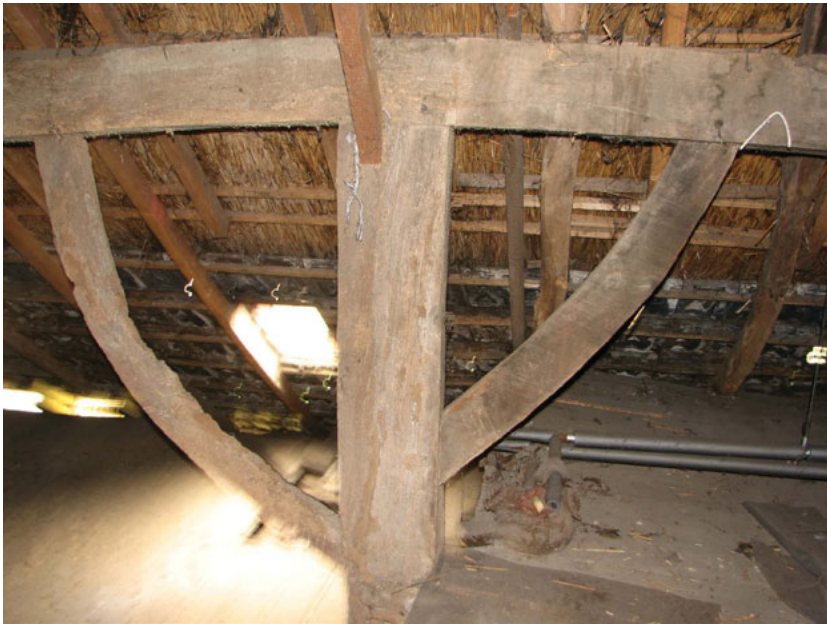
Ankerbalkgebint op as C; de noordelijke gebintplaat loopt hier nog door. Bij de restauratie is de gebintplaat links van de linker schoor vervangen. Op beide schoren is een gekrast telmerk zichtbaar: IIII (foto: 2007 voor restauratie)
