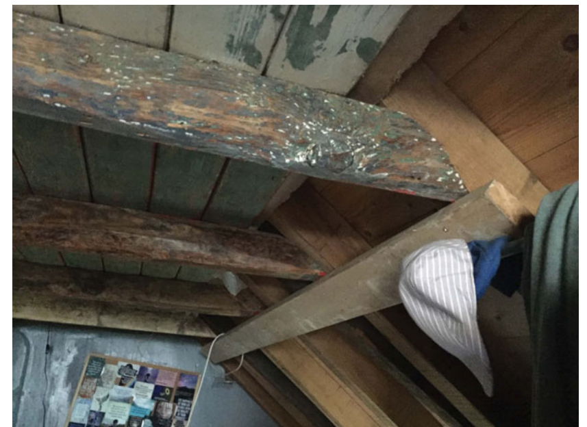
Ruimte 6, de opkamer, balklaag van oude gehakte balken (foto: 2015)
