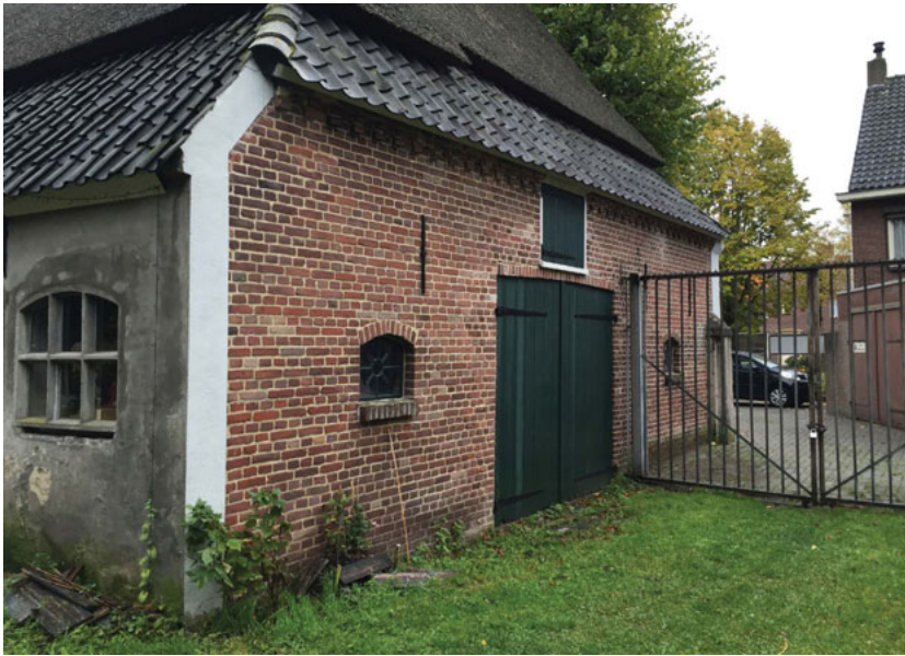
Westgevel (foto: 2015), gerenoveerd in 2003. Het metselwerk is schoongemaakt en gevoegd en de dubbele staldeur met de getoogde rollaag erboven is weer teruggebracht. De gepleisterde beëindigingen zijn bij de restauratie in 2005 aangebracht
