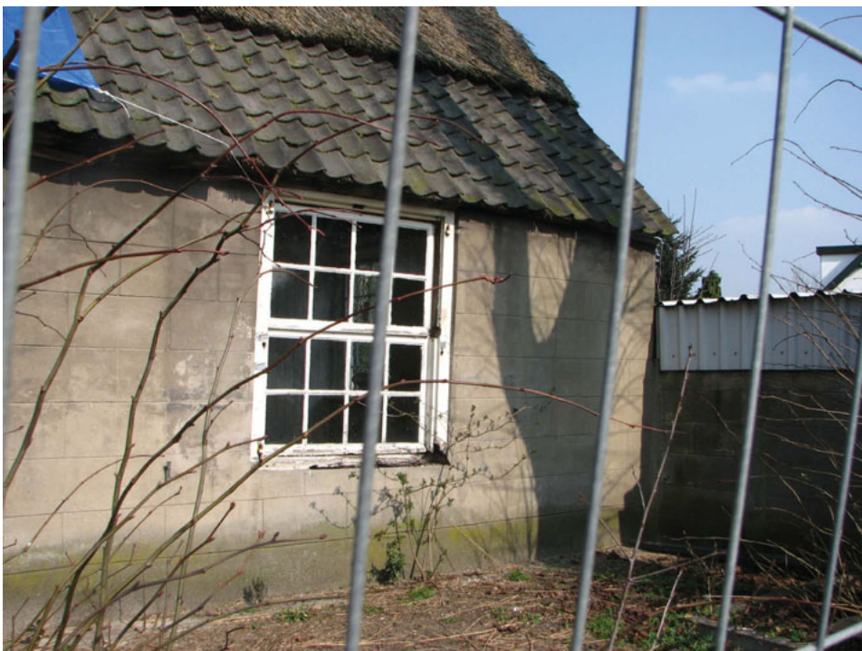
Zuidgevel (foto: 2007, voor restauratie); kozijnen in Ruimte 3, de woonkamer. Zichtbaar is dat dit kozijn een middenkalf heeft gehad en dat het raam boven het kalf meer naar voren stond. De restanten van de duimen halverwege de kozijnstijlen tonen aan dat hier in een eerdere fase halve luiken voor het onderraam hebben gezeten. In een latere fase (XXa?) is het kalf verwijderd en het bovenraam op het onderraam geplaatst en als valraam uitgevoerd, net als bij het kozijn in ruimte 10. Door het naar achteren plaatsen van het bovenraam was het mogelijk een doorgaande luikspanning te maken voor luiken die het hele raam konden afdekken. De drie raamkozijnen in de zuidgevel en de twee kozijnen van de woonkamer in de oostgevel zijn allemaal op deze manier gemoderniseerd. Boven- en onderramen hebben een 8-vaks ruitverdeling gekregen
