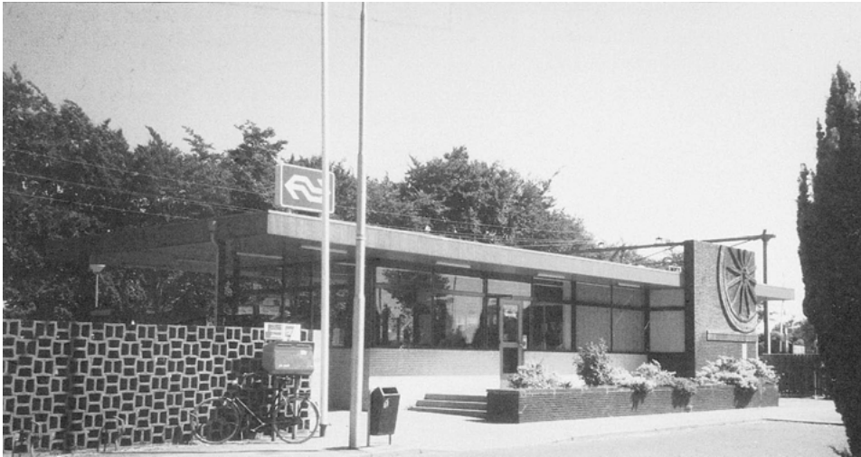
station Wierden - type Bunde (C. Douma 1964-1965) (foto uit: C. Douma, Stationsarchitectuur in Nederland 1838 – 1998)
