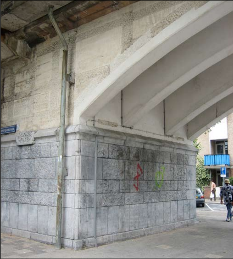
Voorbeeld van opengewerkte holle constructie, classicistische rustica afwerking en decoratief stucwerk.
