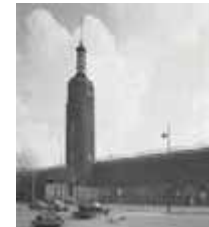
Museum Boijmans architect: A van der Steur
