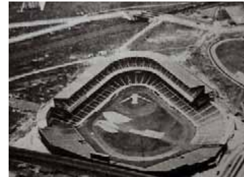
Stadion New York Yankees Bij Amerikaanse honkbalstadions wordt regelmatig gebruik gemaakt van boven elkaar geplaatste tribunes. Deze tribunes worden echter niet als vrijdragende constructie uitgevoerd
