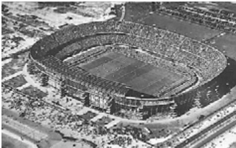
Stadion Feyenoord In de Kuip worden verschillende esthetische, constructieve en programmatische vernieuwingen samengebracht in één harmonisch geheel. Dit integrale karakter van het ontwerp bepaalt in belangrijke mate de kwaliteit van het monument
