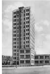
GEB-toren architect: A. van der Steur W.G. Witteveen, A. Poot
