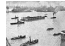
Start bouw Maastunnel
