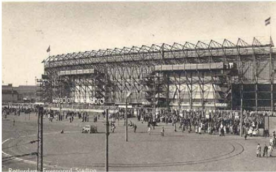
Rotterdam Feijenoord Stadion
