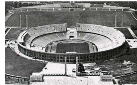
Olympisch Stadion Berlijn Net als bij het Stadion Feyenoord wordt de constructie, bouwtypologie, en esthetiek als één harmonisch geheel ontworpen. In tegenstelling tot de Kuip wordt de constructie echter weggestopt achter marmeren platen
