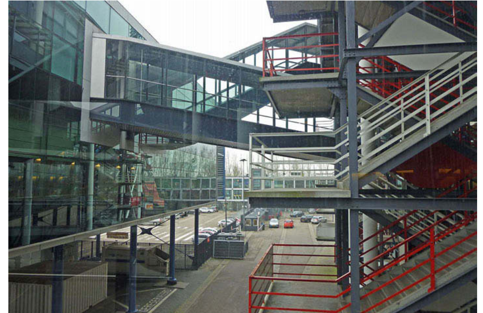
Verbindende luchtbruggen tussen Maasgebouw en stadion
