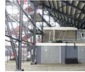
Stadion Feyenoord: staalconstructie in het zicht
