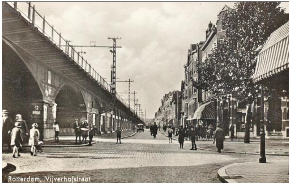
Hofpleinviaduct aan de Vijverhofstraat, ter hoogte van de Teilingerstraat (jaartal onbekend)
