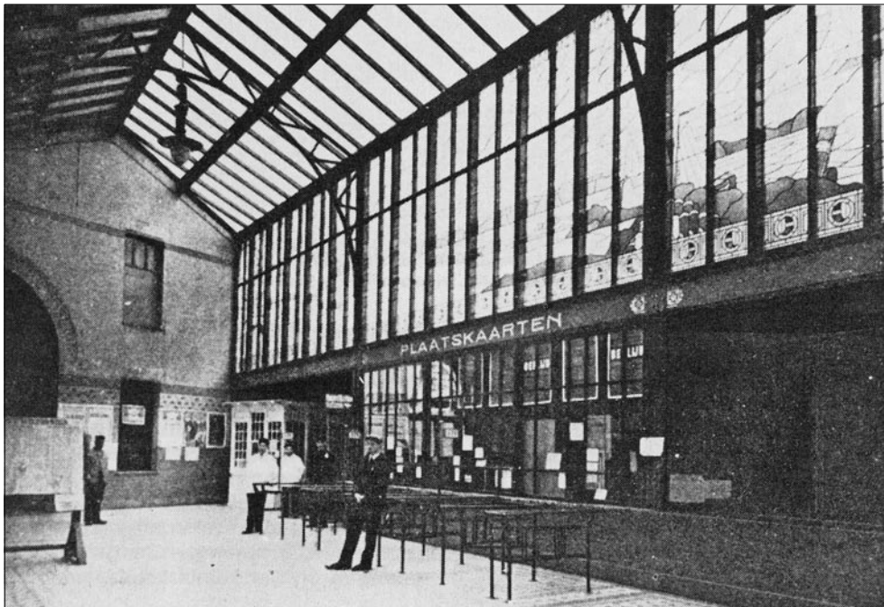
Interieur van het stationsgebouw, uit: J.F. Smit, Rotterdam Hofplein, Den Haag-Scheveningen Kurhaus, Rotterdam 1989
