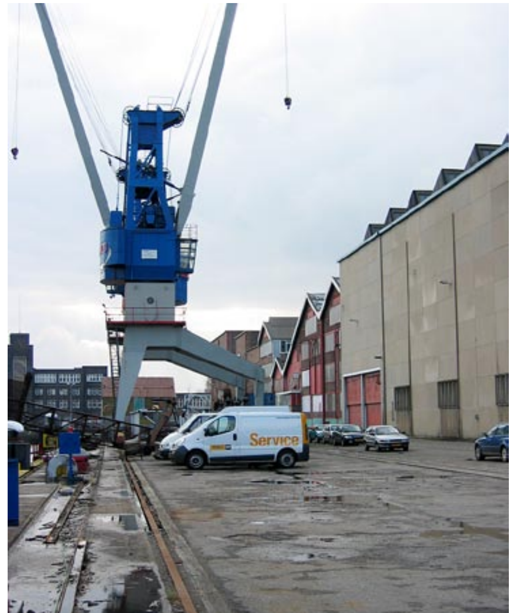
Kraan en kraanbaan westzijde Dokhaven, 2005
