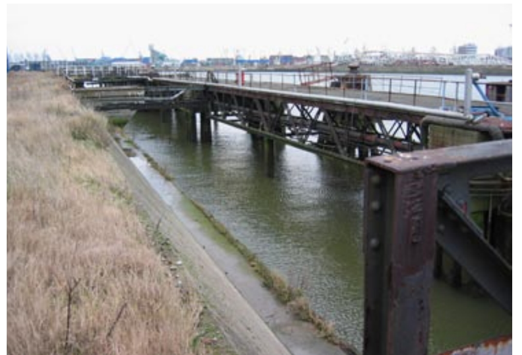
Restanten pieren en kaanbanen in Heysehaven, 2005
