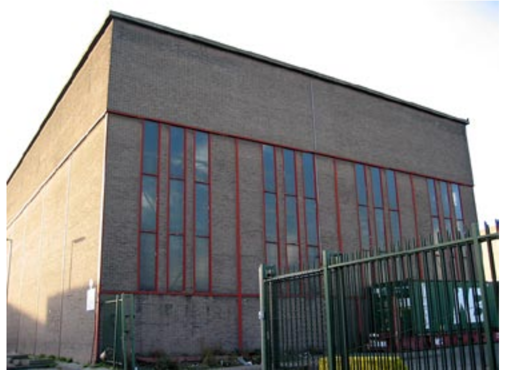
Kopgevel oostelijke magazijnen, 2005
