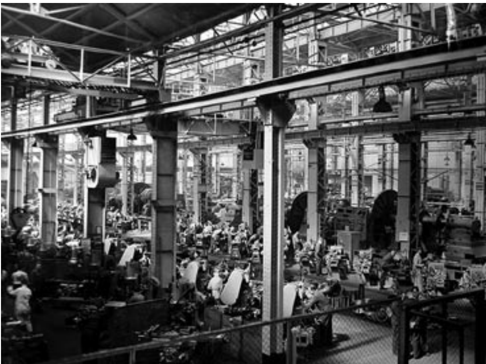
Interieur Machinefabriek jaren 50
