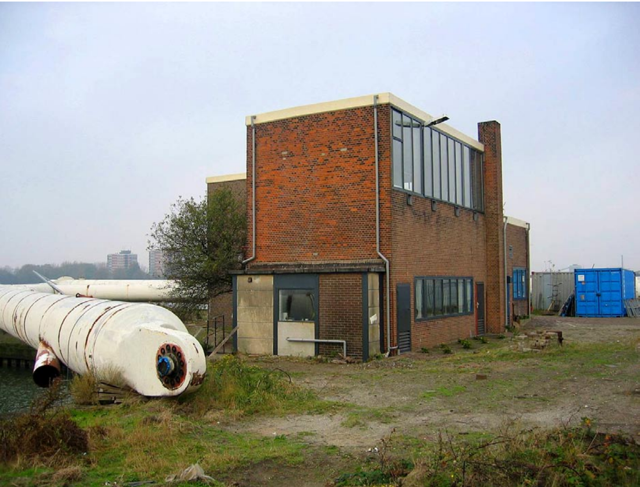
Gebouw voor carbidopslag en acetyleeninstallatie, 2005
