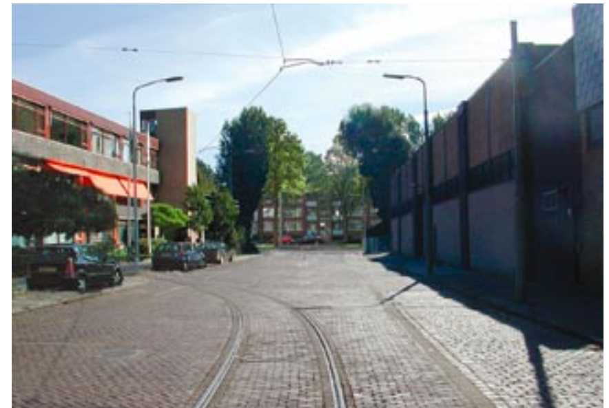
nieuwe situatie Tinwerf, het bedrijventerrein is aangetakt op de Meppelweg en door herinrichting zichtbaar gemaakt.
