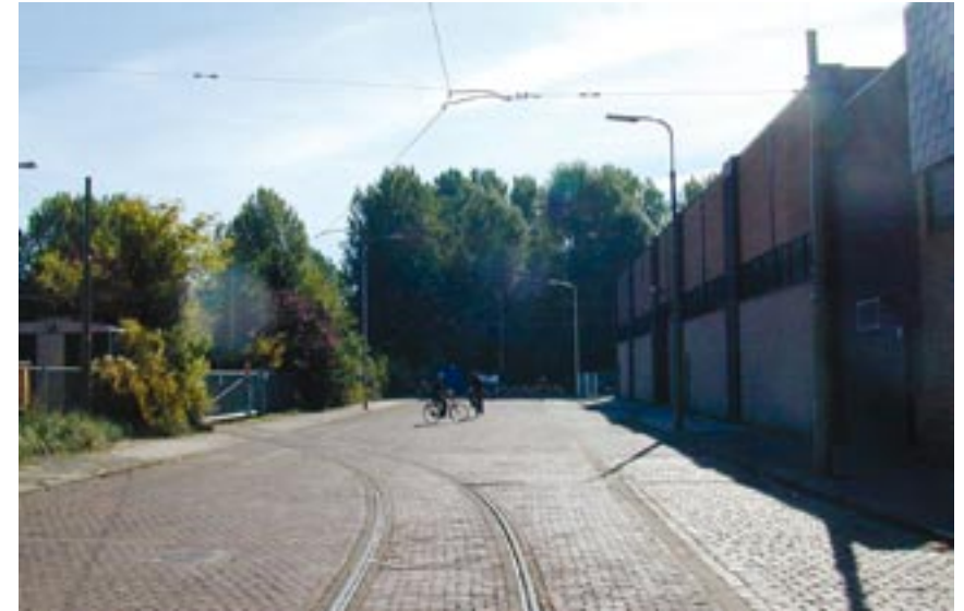
bestaande situatie Tinwerf.
