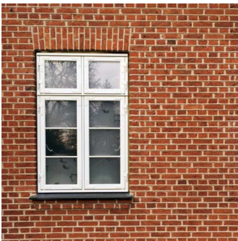
Fig.10. Det smukke hovedhus er opført med symmetri, rød tegl på facader og tage og flotte bygningsdetaljer som f.eks. vinduerne med hvidmalede trærammer. Hovedhuset skal bevares.
