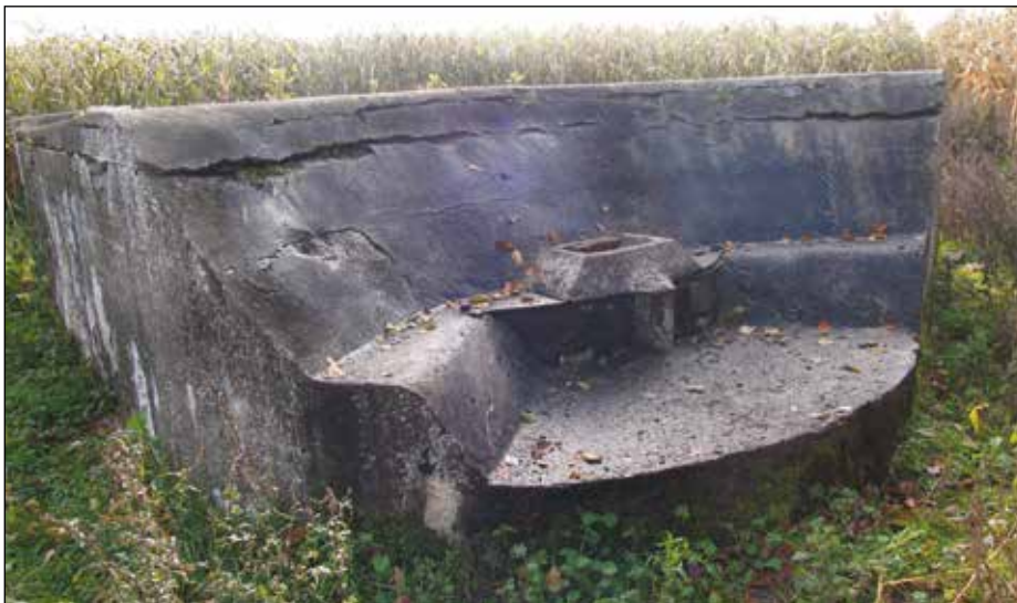
Observationsbunker med periskophul set udefra ved Langdyssevej.
