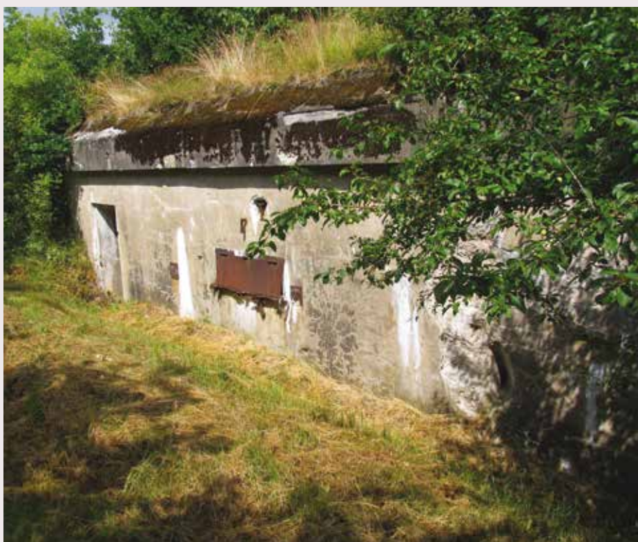
Ammunitionsbunker i Andholm med udlangeråbning.
