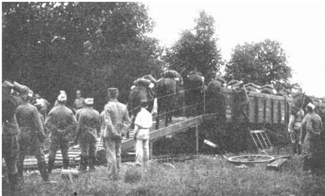
Hjulrampe i funktion - Gardehusarregimentet indlader heste ved Ryvangen 4 . Det ene af de to transporthjul ses til højre i billedet.
