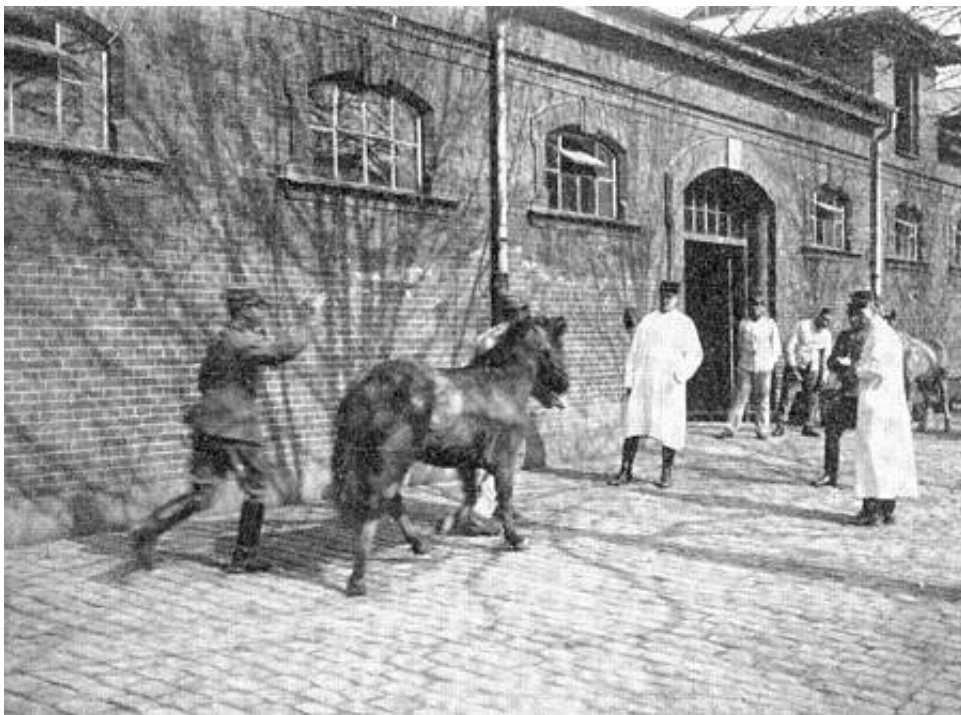
Ved sygestalden. Fra Kilde 2.
