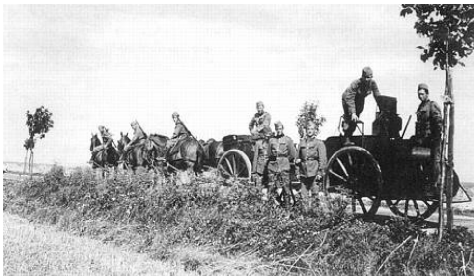
Multikabelkolonne. Fra Kilde 6.
