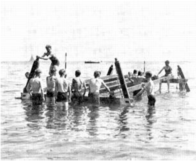
Bygning af anlægsbro (svær normalbro). Fra Kilde 4.
