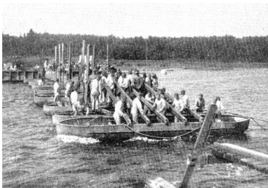
Slagning af normalbro. Fra Kilde 7.
