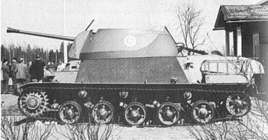
Der Landsverk L62, wie der Typ vom Werk bezeichnet wurde, bestand im Wesentlichen aus einem Landsverk L60-Chassis, auf dem ein Turm mit einer 40-mm-Flugabwehrkanone L/60 montiert war.
