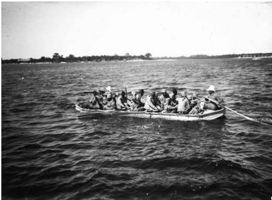
6: En tysk bærbar båd, Dar-es-Salaam, ca. 1910. Fra kilde 3.
