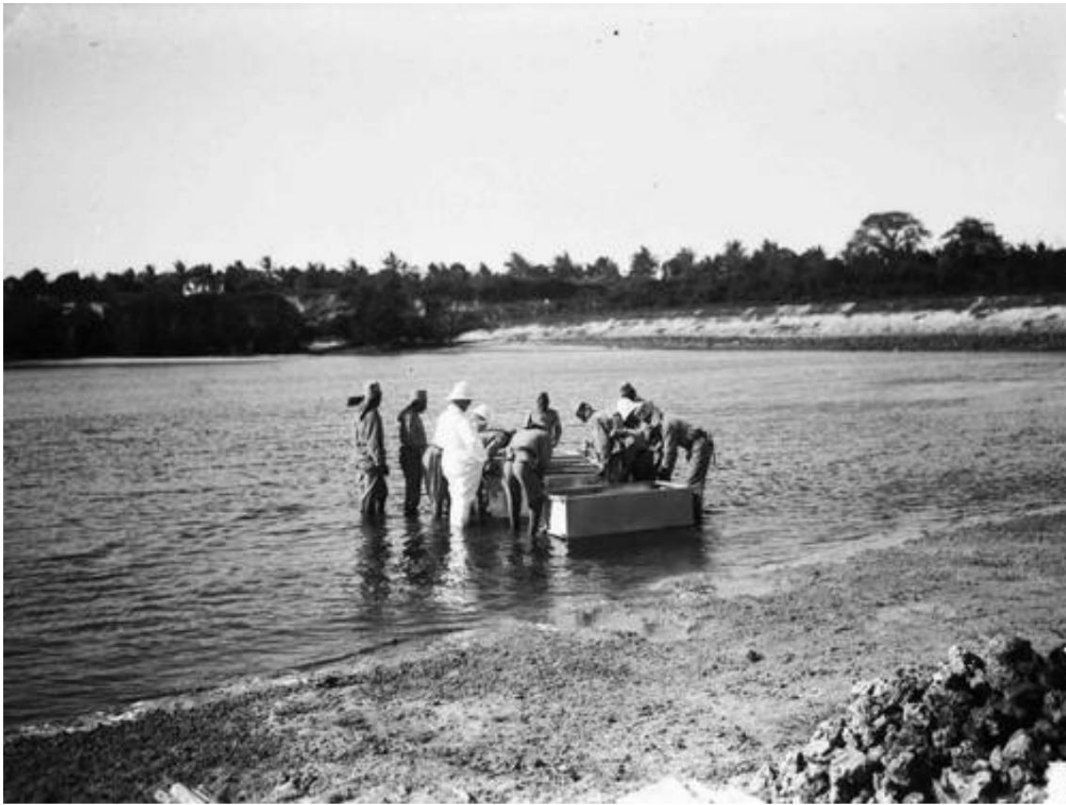
1: En tysk bærbar båd, Dar-es-Salaam, ca. 1910. Fra kilde 3.
