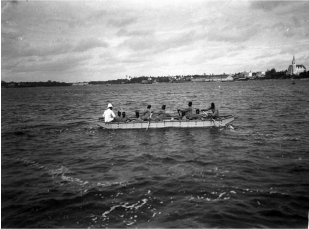
2: En tysk bærbar båd, Dar-es-Salaam, ca. 1910. Fra kilde 3.
