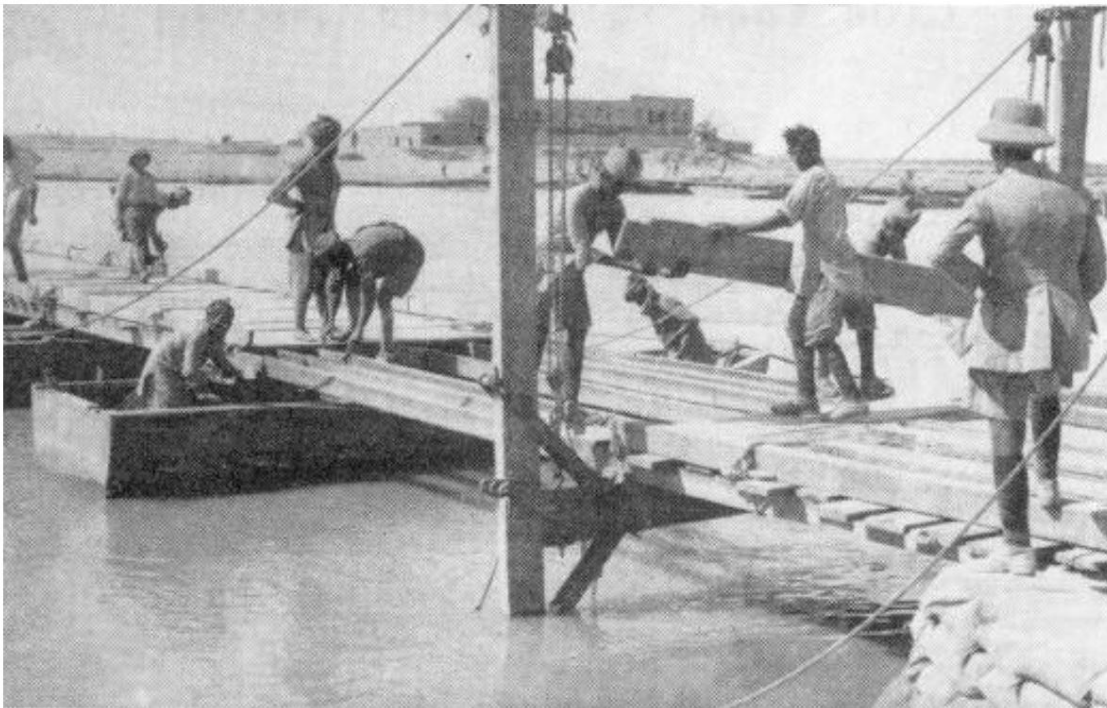
Des pionniers indiens construisent un pont à colonnes lumineuses sur le Tigre, 1917.
