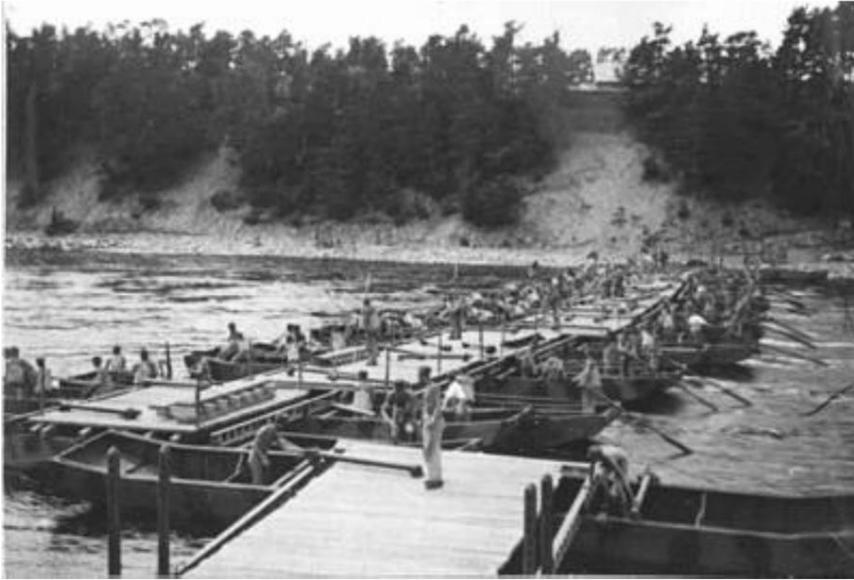
Pont flottant de 125 m de long sur Dalälven, à Laxön ; capacité de charge 15 tonnes.
