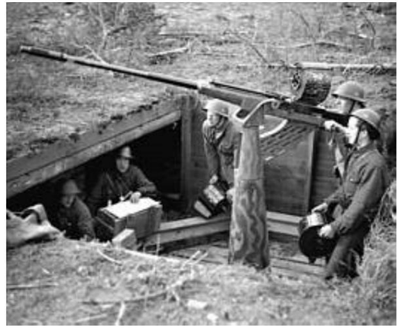
Mitrailleuse de 20 mm avec support anti- aérien fixe de 40 pouces. De Source 6.
