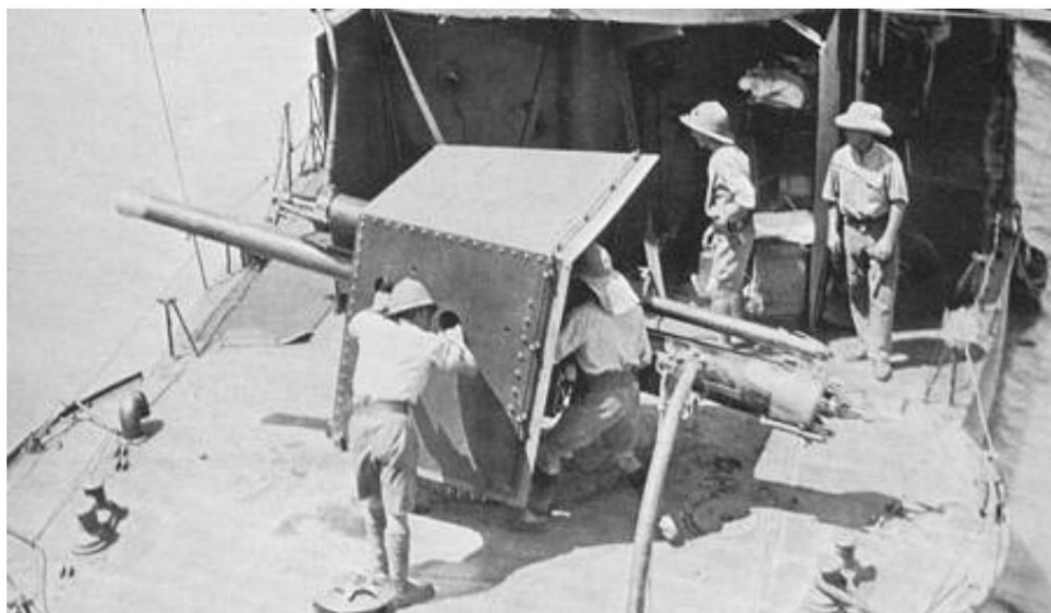
Canon de 4" monté sur le pont avant du HMS Firefly. De Source 3.
