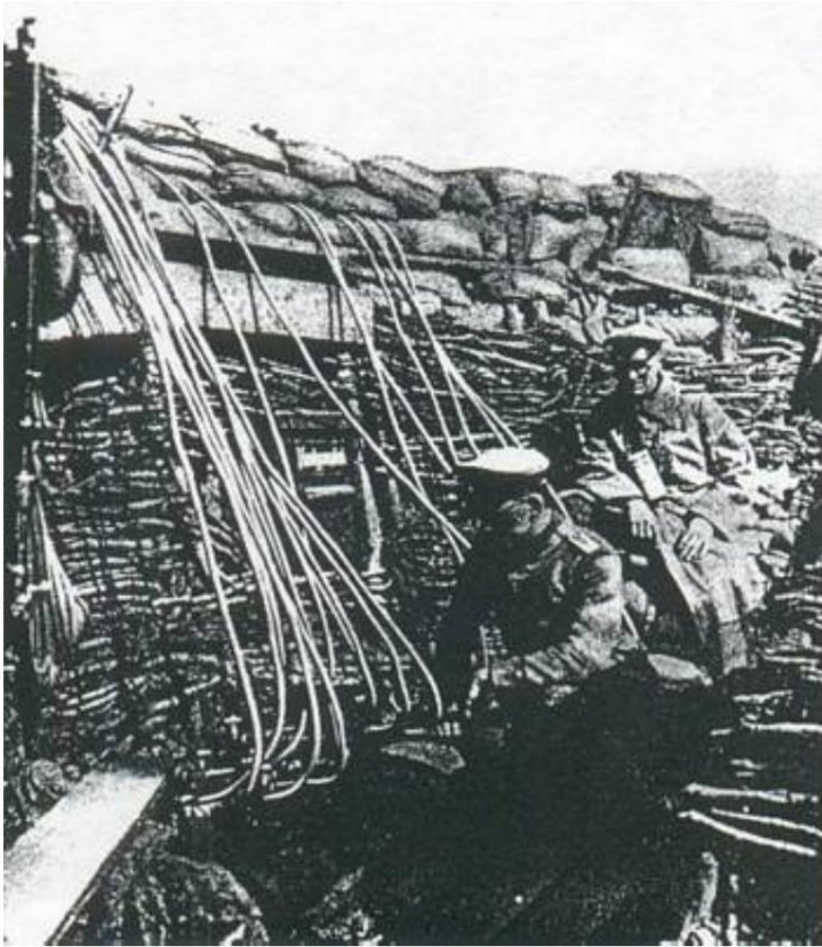
Deutsche Chlorstrahlanlage in einem Graben. Von Quelle 1.
