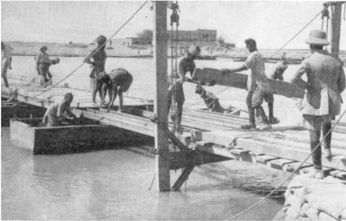
Indische Pioniere bauen 1917 eine Lichtsäulenbrücke über den Tigris.
