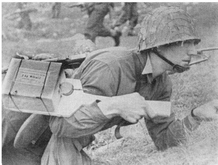
Une charge explosive est avancée. De Source 8.
