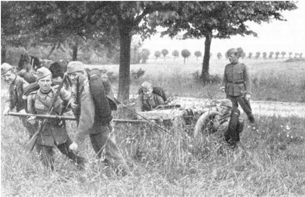
Un camion de mortier est déplacé par la main-d'œuvre, Livgarden, 1932. De Source 6.
