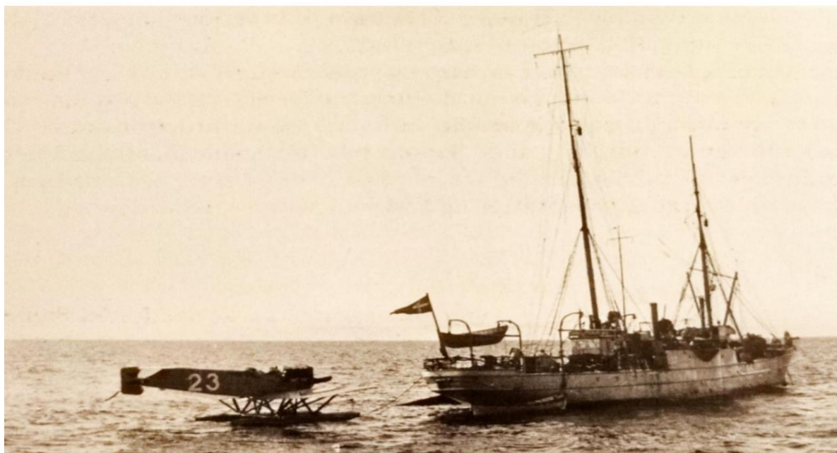
Le navire-atelier Grønsund avec un sous-marin à bâbord et l'un des avions HM II de la marine à l'arrière. Après qu'Henrik Gerner eut pris le commandement (1928), Grønsund fut aménagé sur l'îlot comme atelier flottant pour les sous-marins. Il est resté ici jusqu'en 1950, date à laquelle le navire de 67 ans a été vendu à la casse (Marinens bibliotek)
