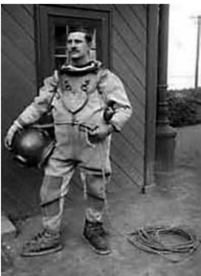
Schwerer Taucher in einem Anzug, der ungefähr so aussieht wie der, den Juel-Brockdorff 1916 trug. Der Anzug wog ca. 70 Kilo. (Foto aus dem Archiv des Orlogsmuseet)
