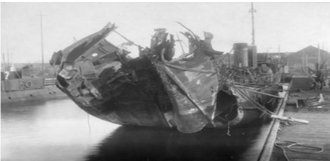
Das Torpedoboot Sværdfisken ist hier zu sehen, nachdem es mit weggeblasenem Heckschiff nach Holmen zurückgekehrt ist, links im Bild ist das U-Boot Nymfen zu sehen. (Foto aus dem Archiv des Orlogsmuseet)
