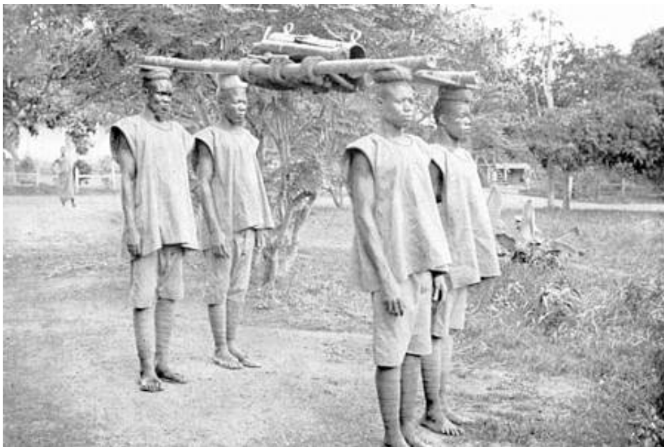
Bærere fra Gold Coast Battery transporterer vuggen til en 2,95-tommers bjergkanon. Selve kanonrøret blev monteret i vuggen. Fra Kilde 3.
