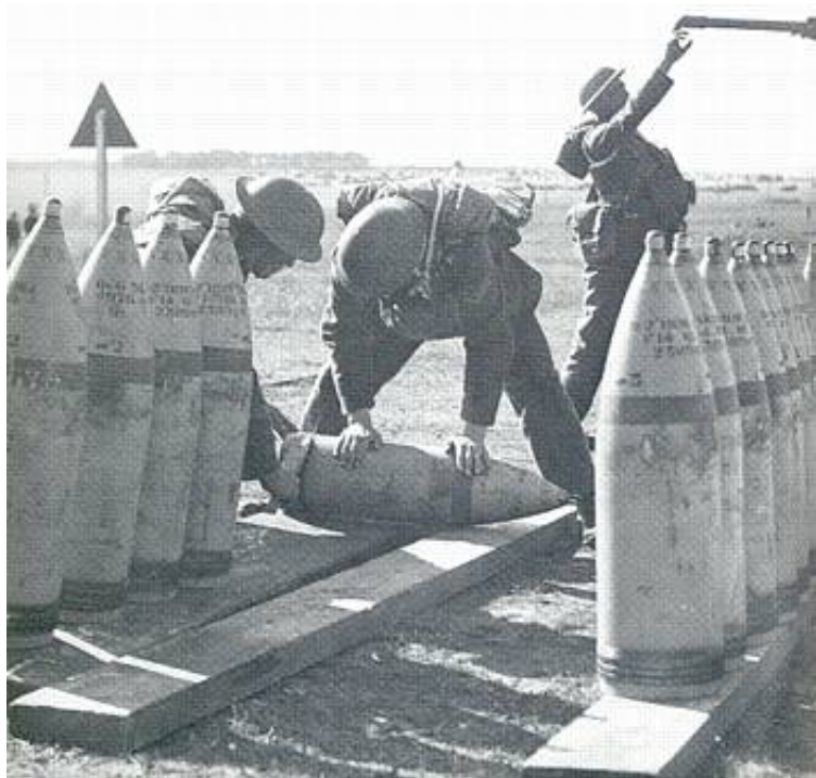
Der gøres klar til at lade en 9,2" haubits. Granaternes "løbebånd" bliver rensed for snavs med en stålørste. Fra Kilde 2.
