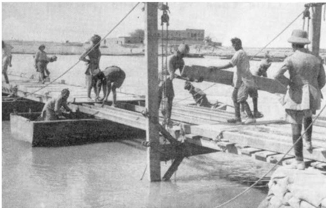
Indiske pionerer slår en Let kolonnebro over Tigris, 1917.
