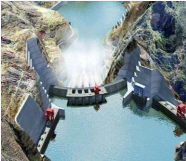
乌东德水电站
