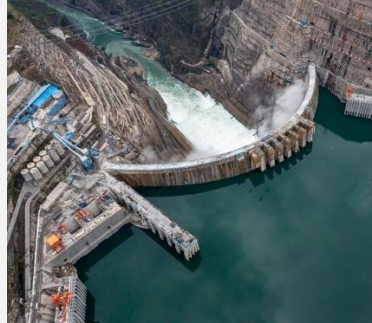
白鹤滩水电站
