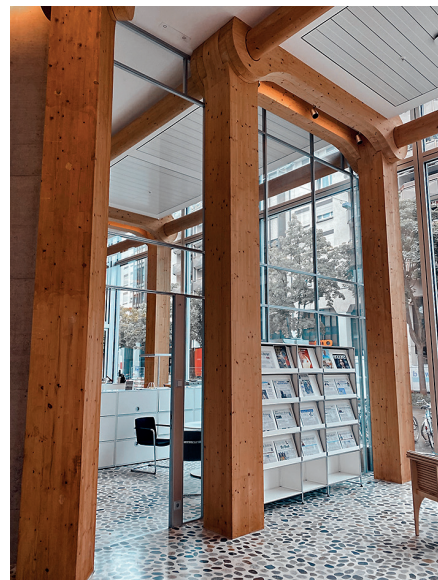
De specialutformade anslutningarna helt i trä.
