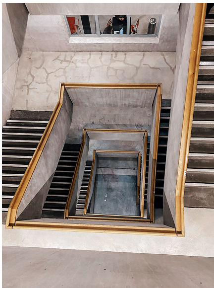
Mycket av betongen från mejeriet var bevarat.
