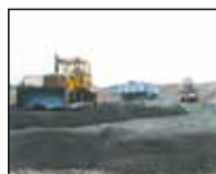
E4-korset N Norrköping byggdes med kolbottenaska som lättballast.
