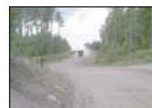
Grusväg N Uppsala byggd med torv/träflygaska och 0-40 grus för 60 tons trafik
