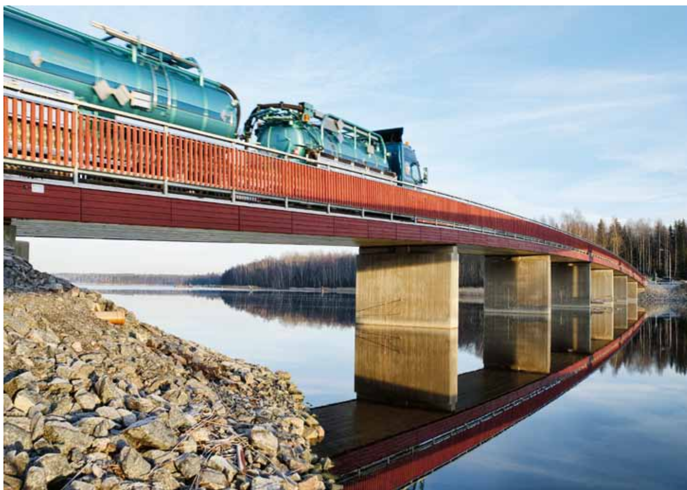
Denna plattbro i trä utanför Iggesund, byggd av Martinsons, har en teknisk livslängd på 80 år.
