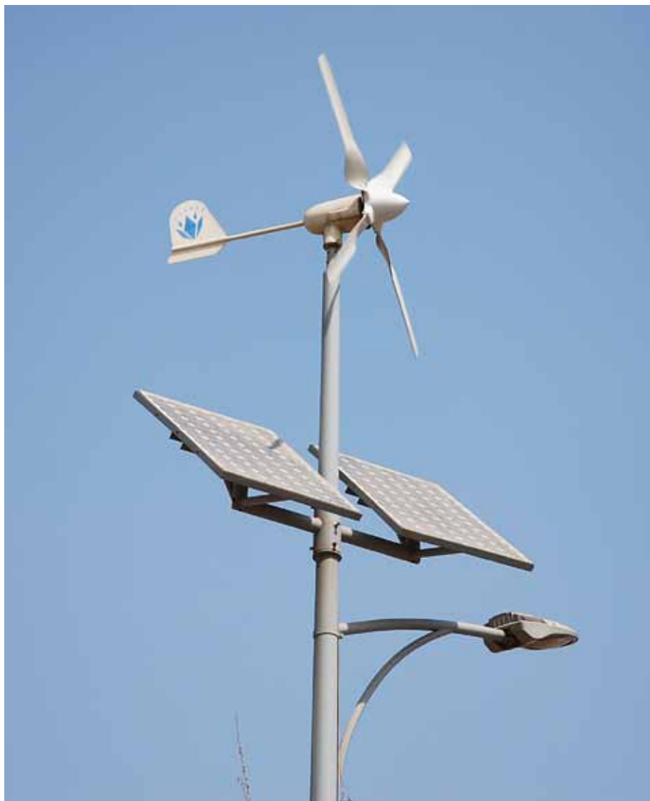
Lyktstolpar försedda med solceller och vindsnurror
