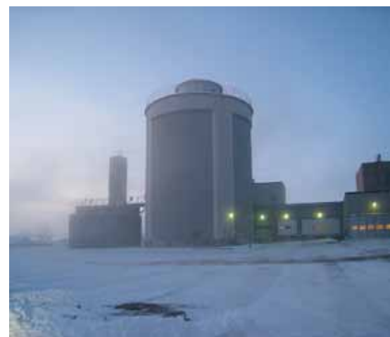
Röttkammaren vid Uddebo avloppsreningsverk i Luleå - lokal energiproduktion med hög potential
