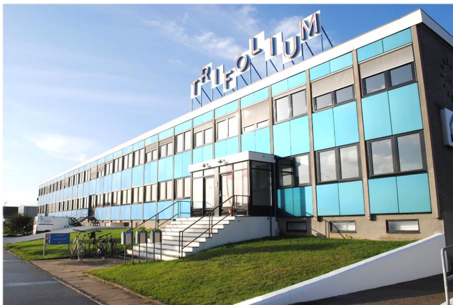
Eksempel på facade integrerede solceller på kontorejendom i Sydhavnen
