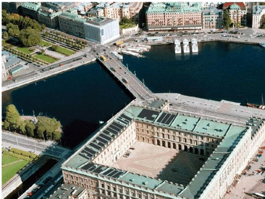
Stockholm Slott. 176 kWp solcelleanlæg installeret af Solar Polaris.
