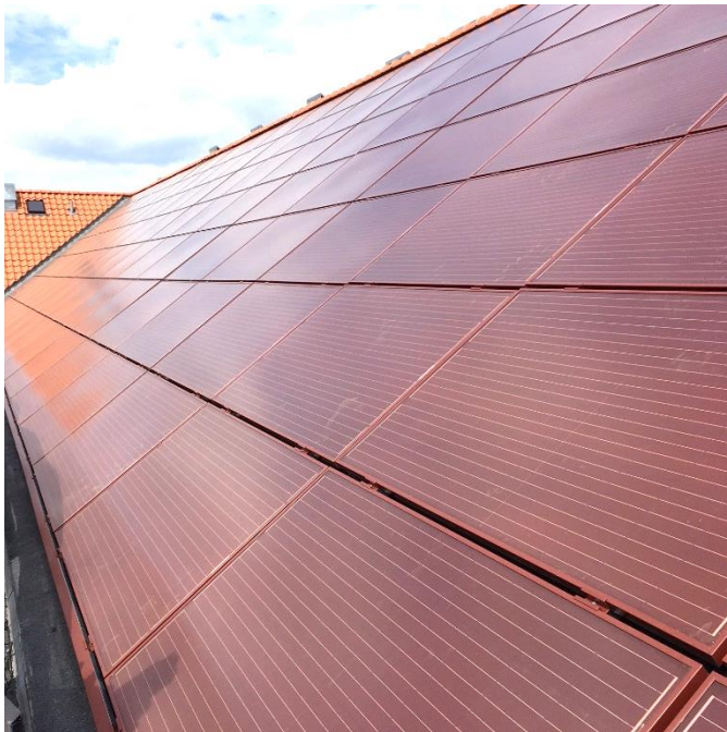
Forsøg med røde solcellepaneler - AB Landsdommergården, Nordvest
