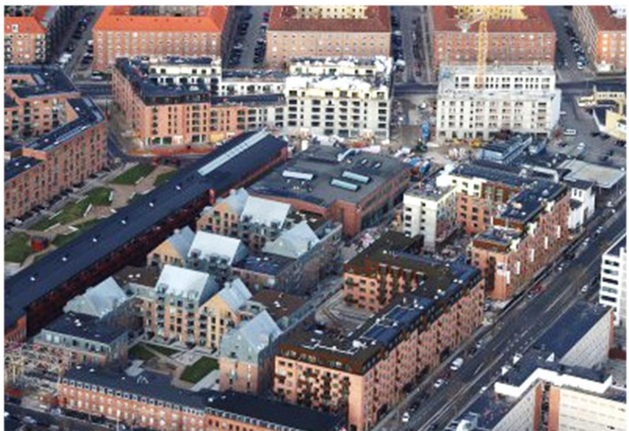
Valby Maskinfabrik, København
