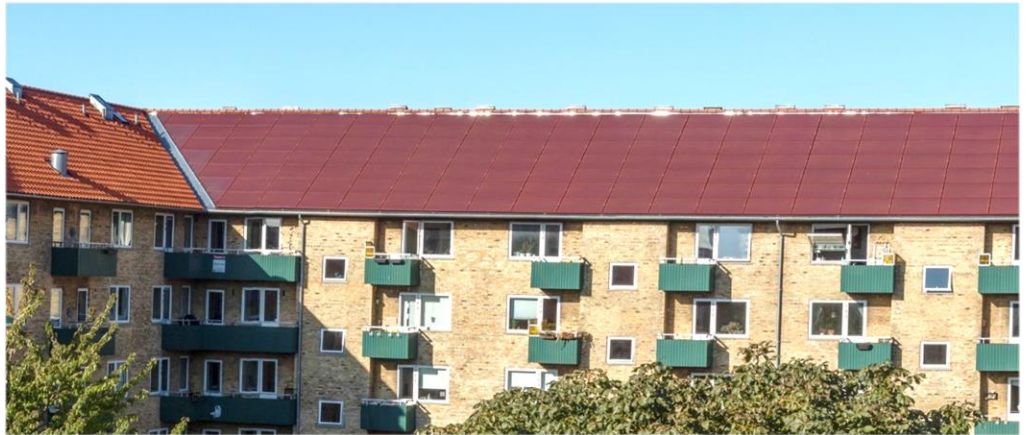
Forsøg med røde solcellepaneler - AB Landsdommergården, Nordvest
