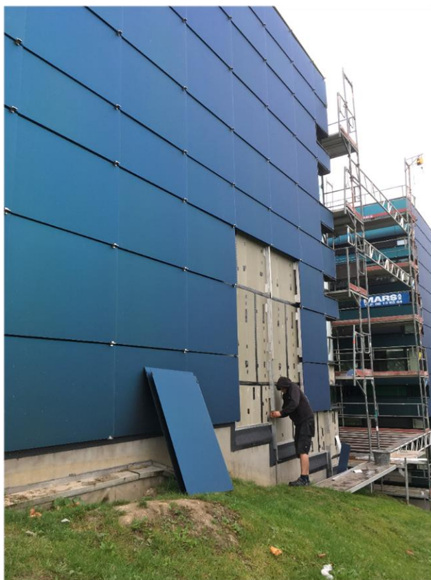
Montering af facadeplader med solceller, Det grønne hus, Aarhus
