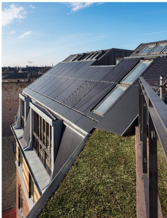
Ryesgade 25. Solceller i kombination med sedumtag
