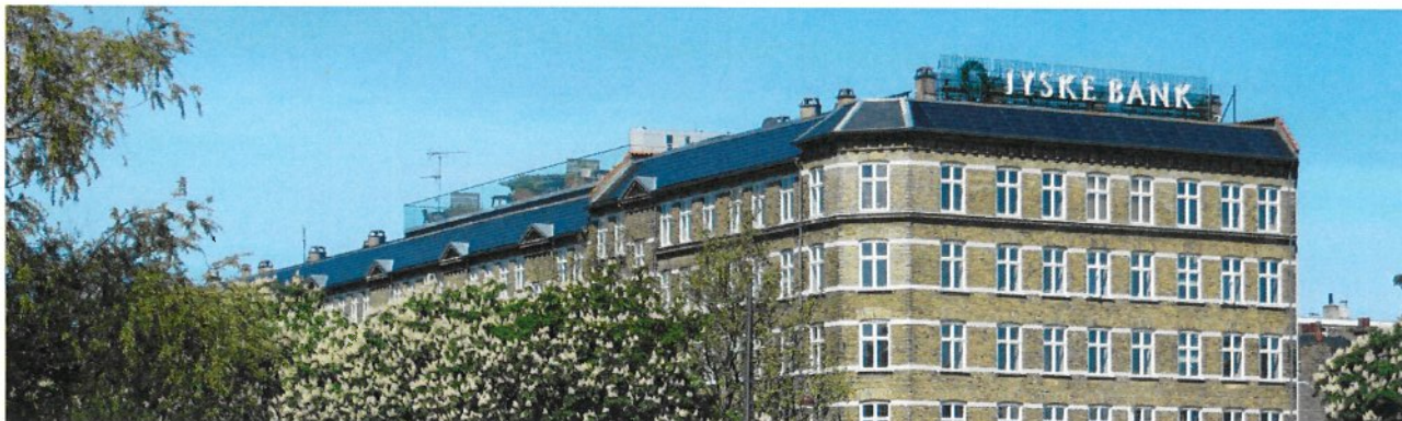
Søpassagen med smalle specialpaneler, på heldækkede tagflader og el-forbruget organiseret internt i andelsboligforeningen.
