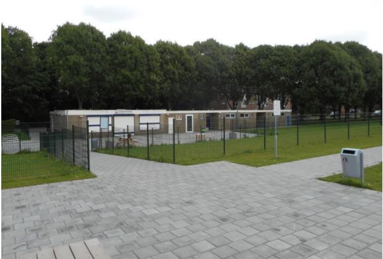
FOTO VAN HET GEBOUW GENOMEN VANUIT DE SPEELTUIN 'SJOEPIENOE'
