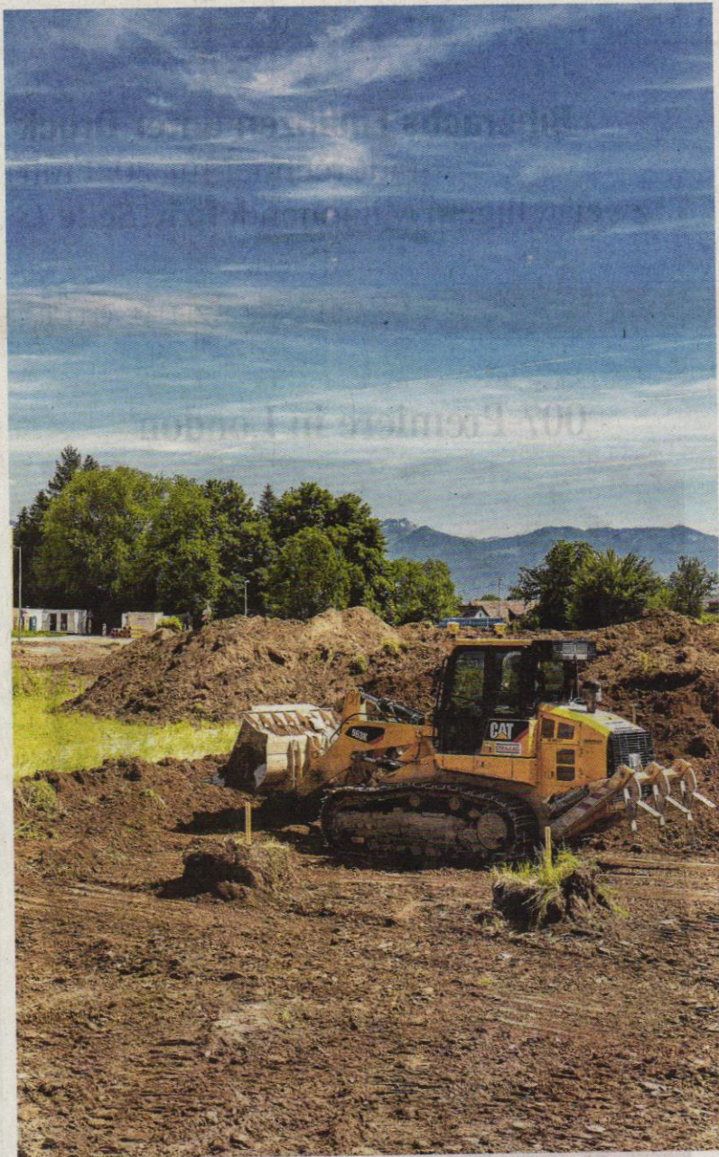
Der Einsatz von Raupenfahrzeugen statt solchen mit Rädern hilft dabei, den Boden bei Bauprojekten nicht zu sehr zu verdichten.
