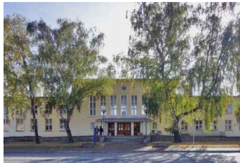
Bild 3: Innenentwicklung mit Perspektive – Wohnen in umgebauter ehemaliger Tuchfabrik in Pritzwalk © TU Kaiserslautern
