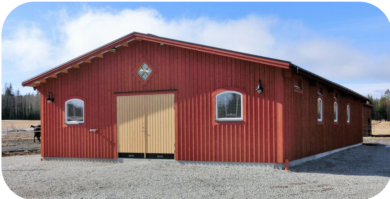
Travhäststall i Dalarna med valvade fabriksmålade fönster. Här målar man även knutbrädorna och vindskivorna i Falurött.
