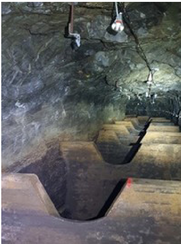
Figur 15. Svartegjel fisketrapp. Foto Morten Kraabøl 2022.
