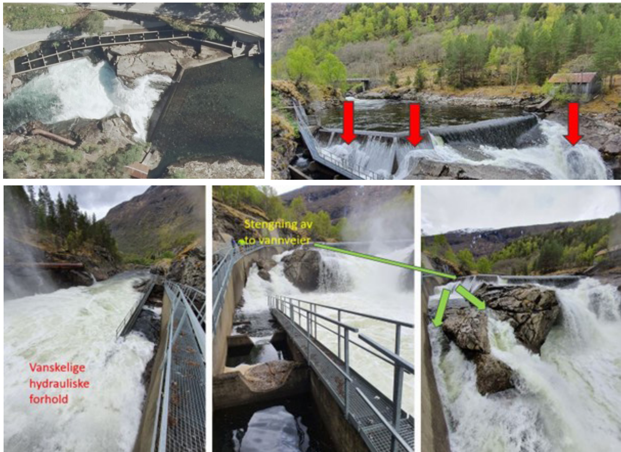
Figur 14. Kolgryte fisketrapp. Røde piler viser områder der en bør unngå overløp med uønskede fall mot berg-betongarmoring. Grønne piler viser vannveier som bør stenges. Tiltak for å redusere dette er beskrevet. Foto Morten Kraabøl 2022.
