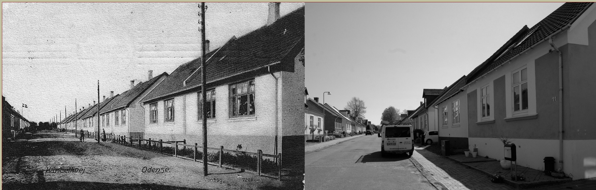
LOKOMOTIVHUSEN PÅ KANCELLIVEJ, BYGGET I 1908-1910, AF "BYGGESELSKABET AF ARBEJDERE VED SYDFYENSKE BANES MASKINVÆRKSTED" HER SET TIL VENSTRE FRA OMKRING 1915 OG TIL HØJRE FRA 2016.
