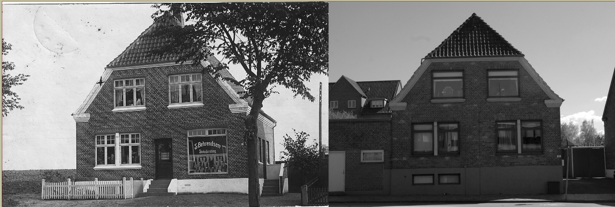
MIDDELFART LANDEVEJ 98, BYGGET I 1915, (BOLBROS FØRSTE POSTEKSPEDITION 1.2.1935—1939) HER SET TIL VENSTRE FRA OMKRING 1917 OG TIL HØJRE FRA 2016. MIDDELFART LANDEVEJ BLEV DEN 20.9.1937 ÆNDRET TIL MIDDELFARTVEJ.
