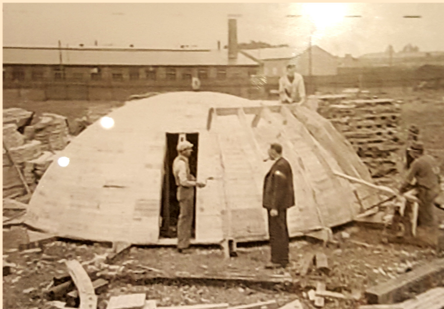
Type I er ved at blive opåført.
