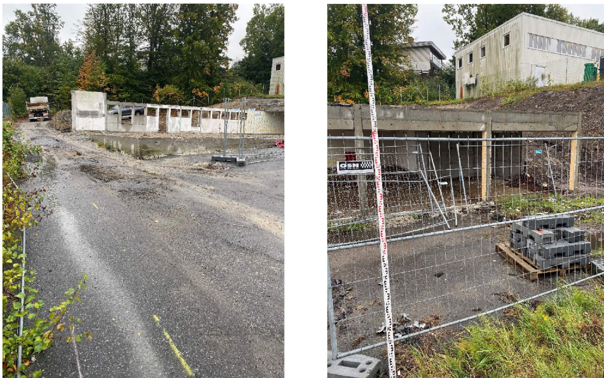
Figur 4: Bilder fra tomta mot sørøst og sør. Bygget lengst sørøst ligger på fjell
