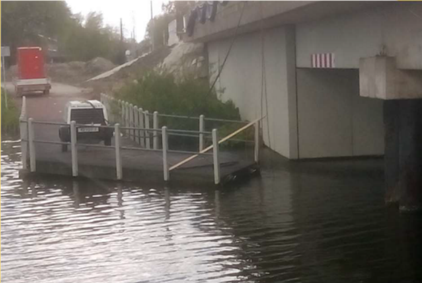
Vlonder wordt onder brug over water geplaatst
