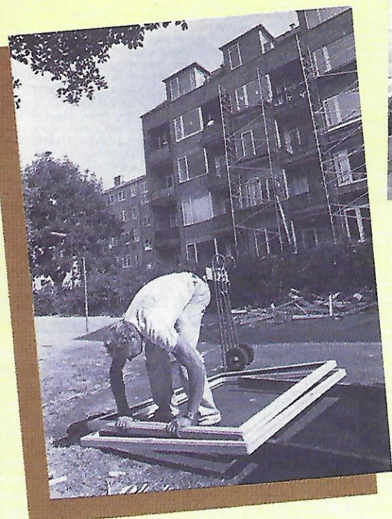
Den store vinduesudskiftning er netop blevet afsluttet.
