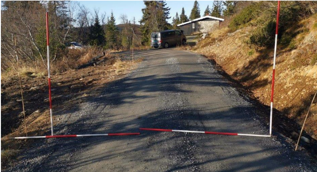
Vegbredde 3,45 meter ved 750 meter. Ny stikkrenne nedlagt.
