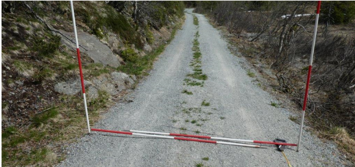
Vegbredde 2,4 meter ved 300 meter. Legg merke til fjell i venstre kant og grus som er frest utover mot høyre
