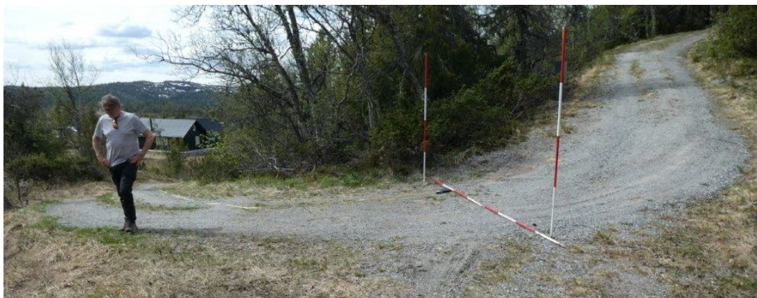
Veg nr 4, vegbredde 3,75 i krapp kurve.
