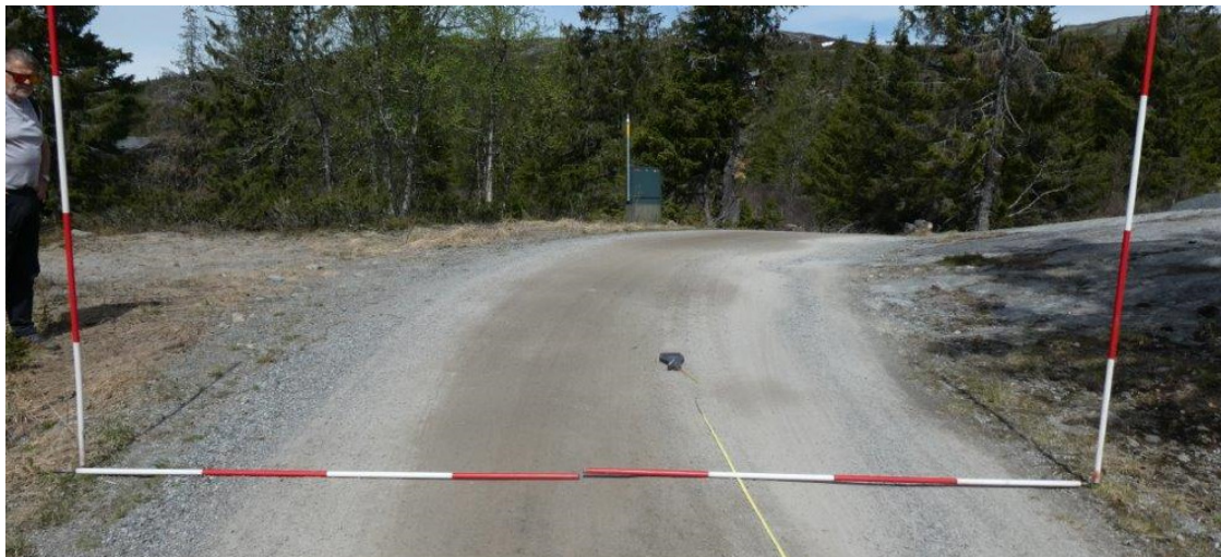
Vegbredde 4 meter ved 550 meter.
