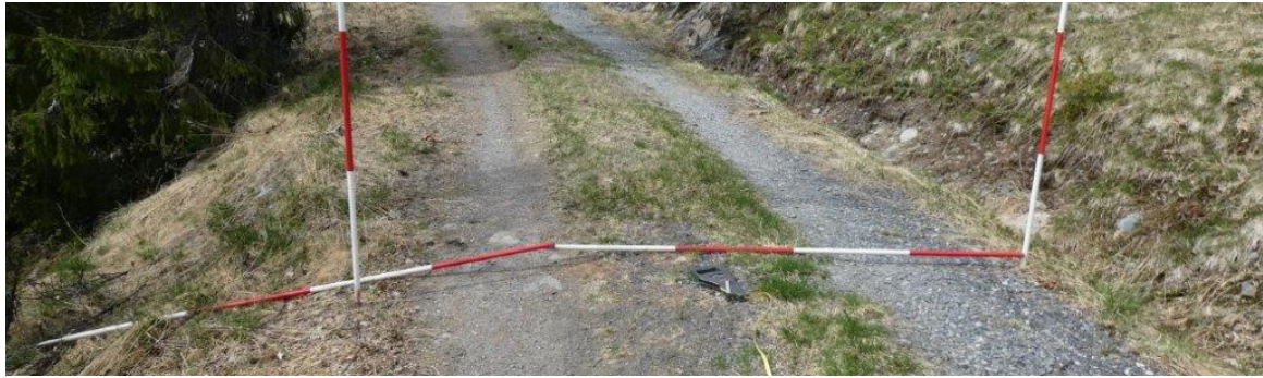
Vegbredde 2,75 meter ved 50 meter.
