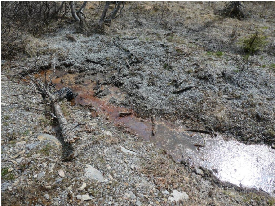
Mye grusmasser frest ut av veger under brøyting.
