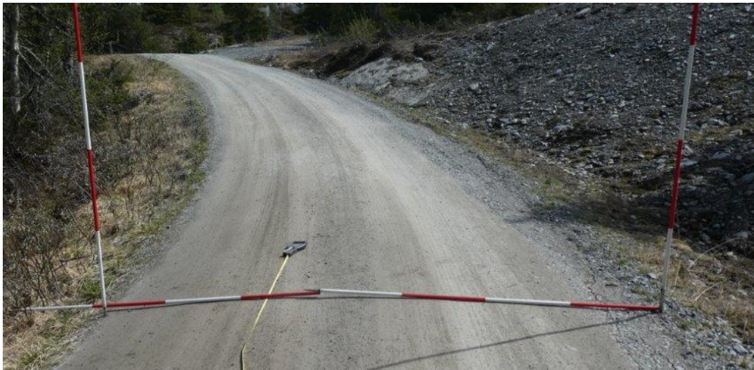
Vegbredde 3,4 meter ved 250 meter.
