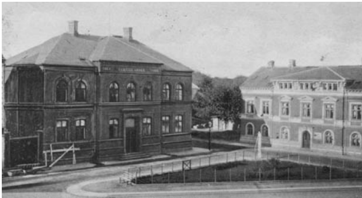
Pumpe på Skoletorvet. Sidst i 1800-tallet blev der opstillet brandpumper på byens torve og pladser.
