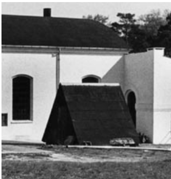
Kalk til vandet blev opbevaret i et lille skur ved vandværket.
