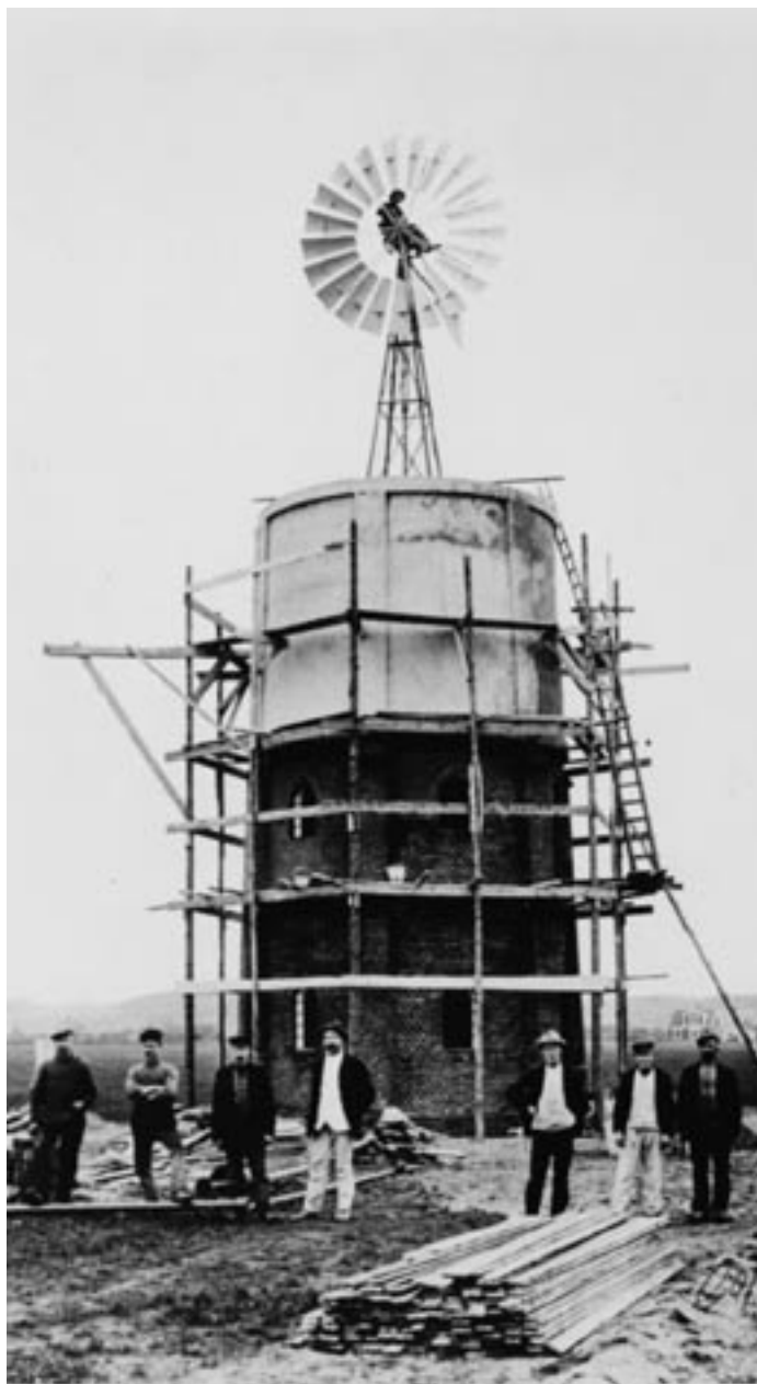
Alderslyst havde eget vandværk med vandtårn, opført i 1909.
