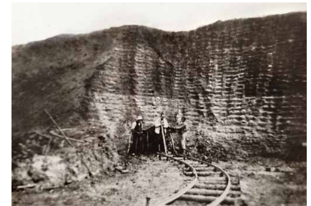
Der blev udlagt tipvognsbaner og med tipvogne kunne råleret nu lettere transporteres fra teglgravene frem til ælteværket.
