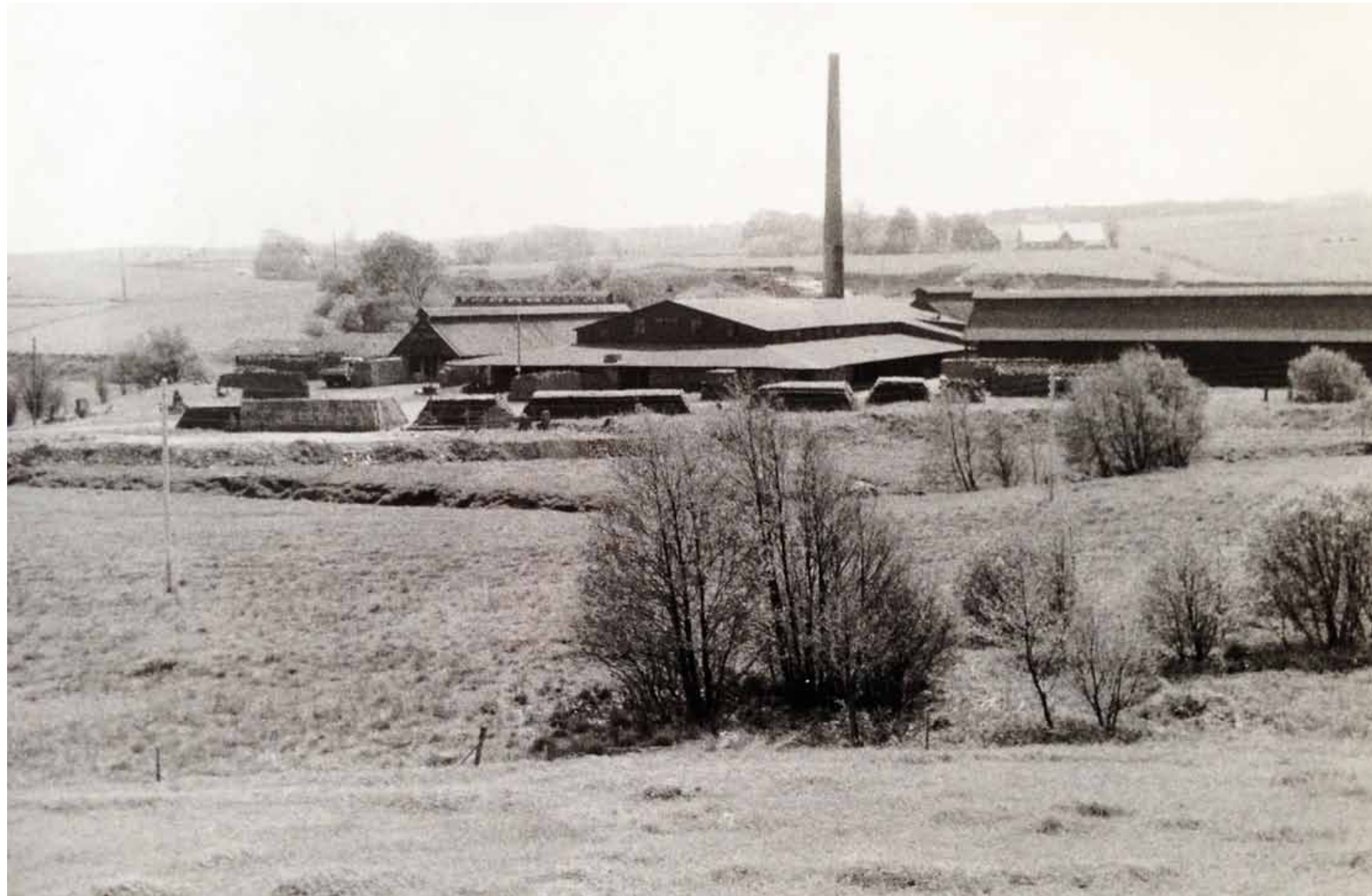
Teglværket i Gjern som det så ud i 1947. I midten ringovnen med skorsten omgivet af tørrelader til begge sider.
