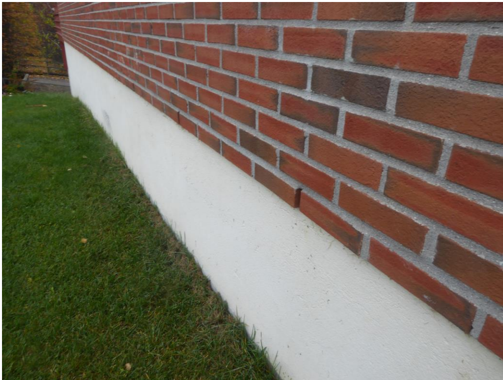
Bilde 1: Grunnmur er godt vedlikeholdt.
