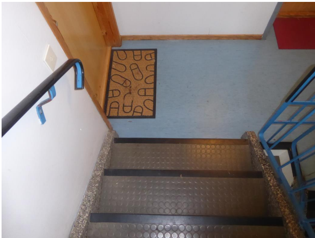
Bilde 4: Sklisikkert belegg i trapp og gode håndløpere på rekkverk. Kontrast i inntrinn er god.
