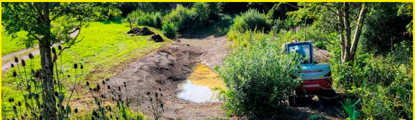
Abb. 19 bis 25 Sanierung der zwei Teile des nördlichen Teiches des Laubfroschbiotopes.
