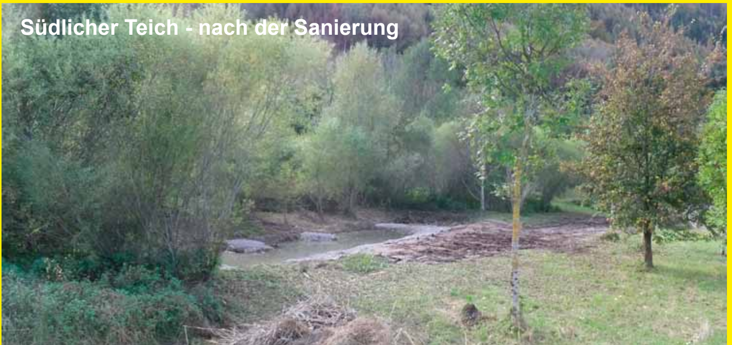
Südlicher Teich - nach der Sanierung bei Wasserhöchststand
